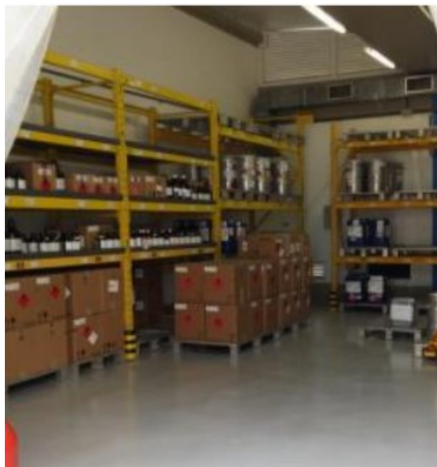
Figura 24: Sala refrigerada de armazenamento de produtos inflamáveis produtivos, como álcool e reagentes, com capacidade de estocagem de 5 m 3 da FÁRMACOS DO BRASIL.
