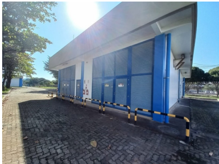
Figura 15: Prédio da subestação de energia da empresa Fármacos do Brasil
