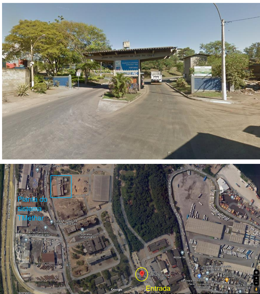
a) Entrada da ETR Caju; b) Vista superior da ETR Caju. Fonte: Google Maps, 2023.
