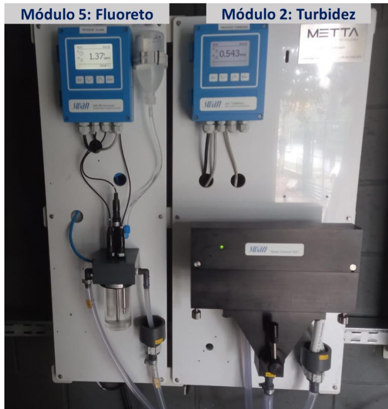
Figura 10 – Módulos de análise de fluoreto e turbidez.
