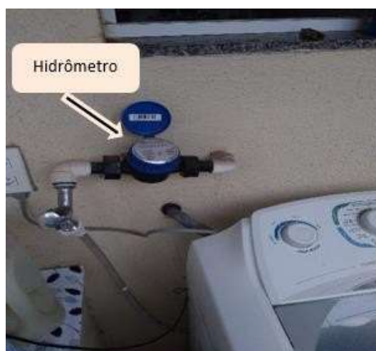
Figura 33 – Hidrômetro (HID-MLR) para registrar o volume de água utilizada por acionamento da máquina de lavar roupas
