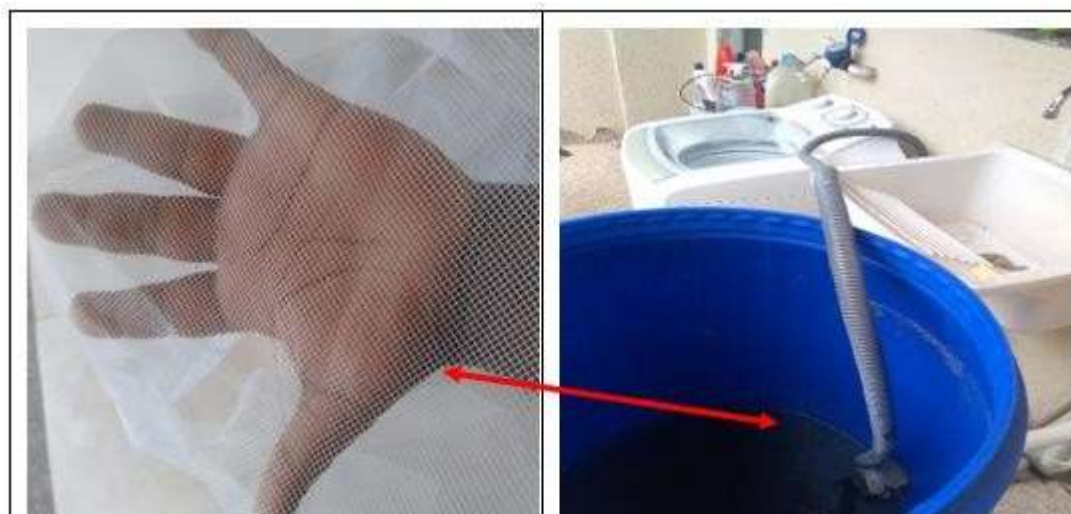
Figura 37 – Gradeamento com tela mosquiteira
