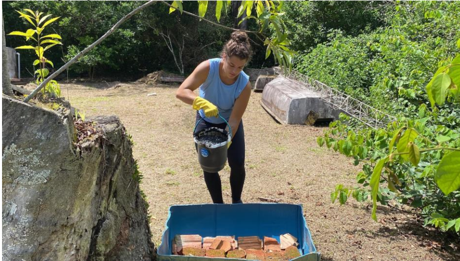
Figura 18 - Disposição do lodo no leito de secagem após sua remoção do tanque séptico
