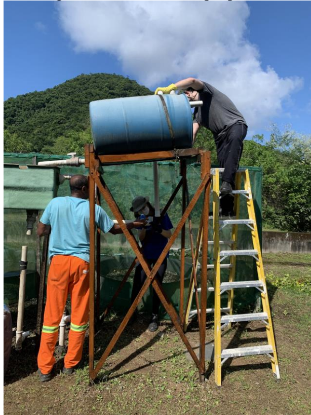
Figura 16 - Troca do tanque pulmão
