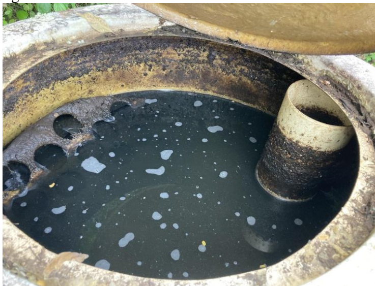
Figura 5 - Vista interna do filtro anaeróbio
