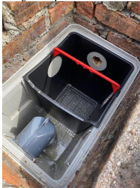
Figura 15 - Instalação da caixa de gordura para o efluente oriundo da cozinha
