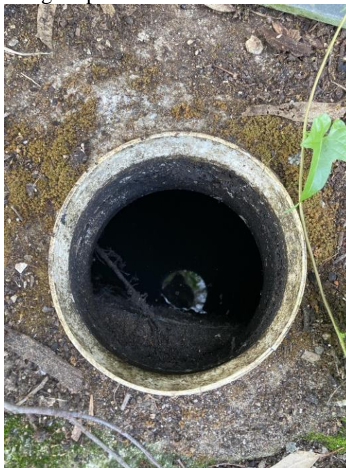
Figura 6 - Sumidouro – Ponto de coleta das amostras do efluente final do Sistema Avançado Anaeróbio de Tratamento de Esgoto para as análises de monitoramento
