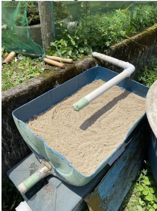
Figura 17 - Montagem da caixa de areia
