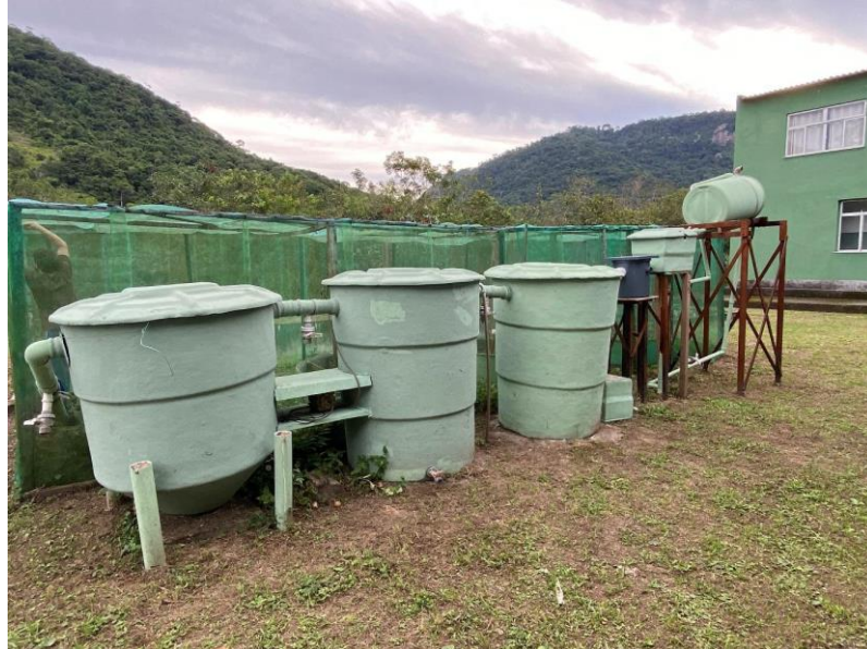
Figura 8 - Ecossistema Engenheirado da direita para esquerda: Tanque pulmão - caixa equalizadora de vazão - de gordura - fossa séptica - filtro aerado – biofiltro misto
