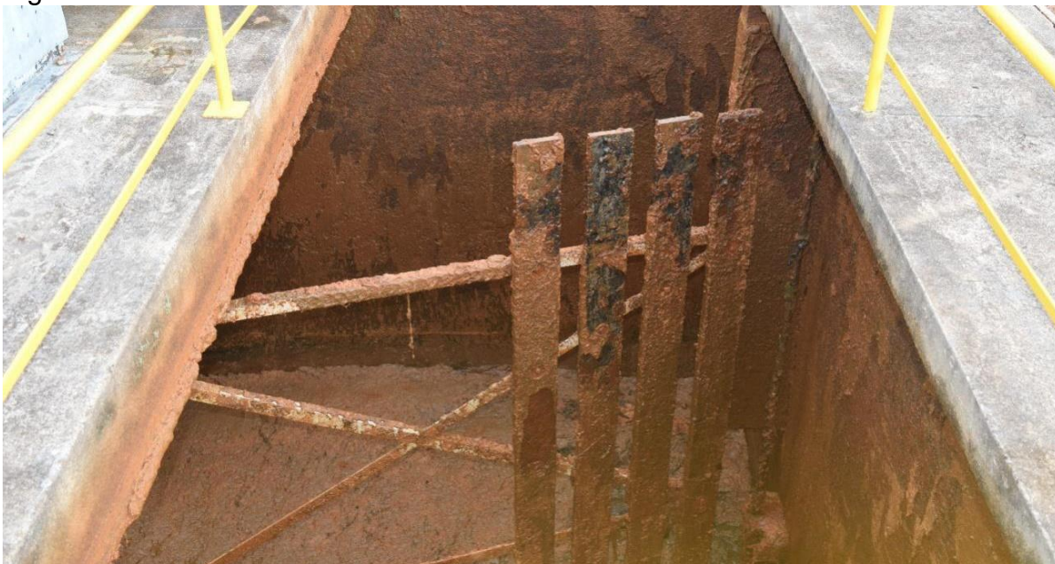
Figura 2 - Flocos aderidos nos floculadores de uma ETA.
