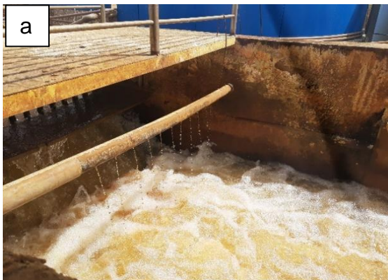
Figura 6 - Etapas de tratamento da ETA a) Adição do coagulante na chegada da água bruta, b) Canal de mistura rápida após a adição de coagulante, c) Floculadores, d) Decantador 1(esq.) e 2(dir.), e) Limpeza manual do decantador, f) Processo de retro lavagem do filtro, g) Produção de Cloro adicionada na etapa de cloração, h) Armazenamento de água tratada para distribuição.
