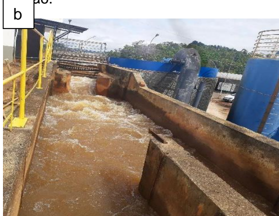
Figura 6 - Etapas de tratamento da ETA a) Adição do coagulante na chegada da água bruta, b) Canal de mistura rápida após a adição de coagulante, c) Floculadores, d) Decantador 1(esq.) e 2(dir.), e) Limpeza manual do decantador, f) Processo de retro lavagem do filtro, g) Produção de Cloro adicionada na etapa de cloração, h) Armazenamento de água tratada para distribuição.
