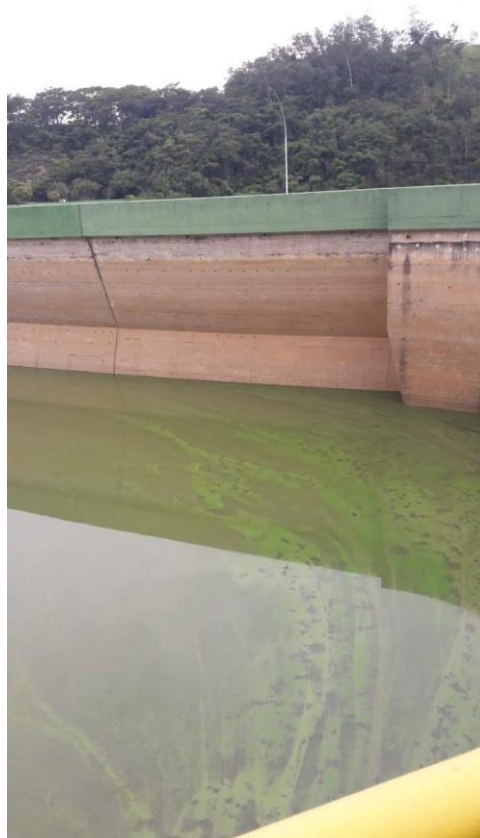
Figura 11 - Represa do Funil com a presença de ponto eutrofizado
