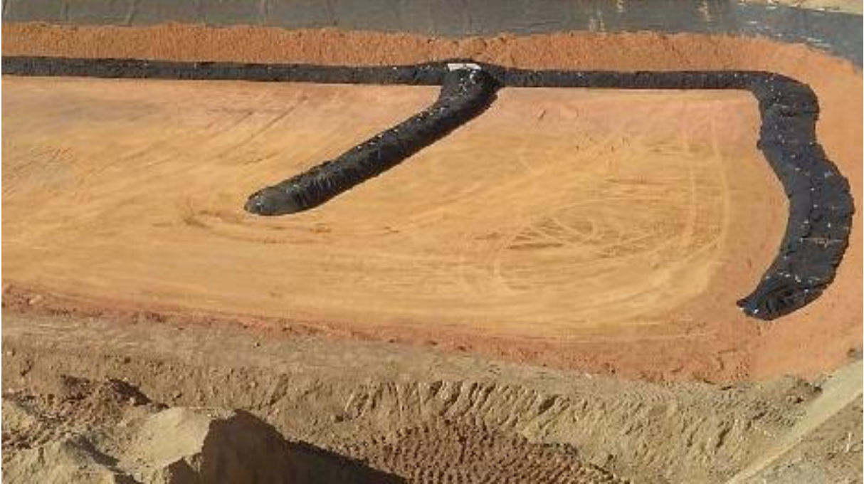
Figura 32 - Geotêxtil não tecido envolvendo os drenos de base. Fonte: CTR.
