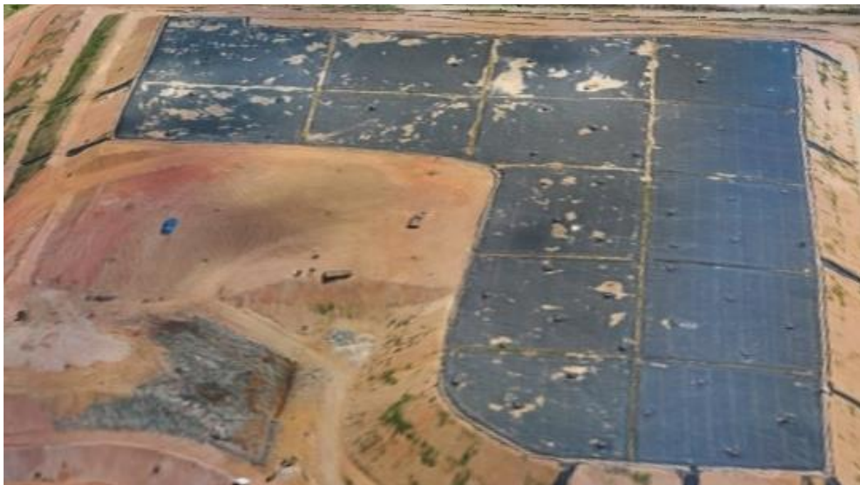
Figura 18 - Cobertura intermediária com geomembrana PEAD. Fonte: CTR.
