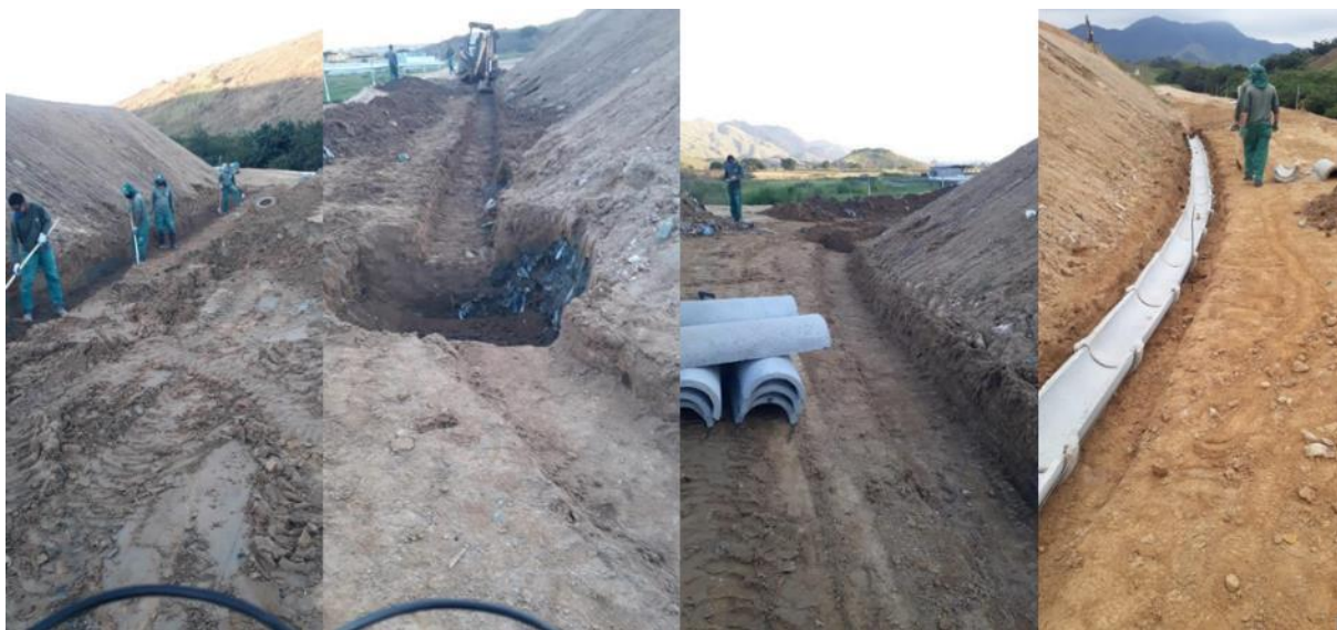
Figura 23 - Sequência de implantação da drenagem pluvial. Fonte: CTR.
