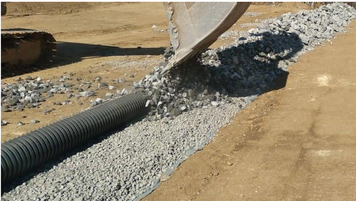
Figura 30 - Leito de brita para acomodação da tubulação do dreno principal. Fonte: CTR.
