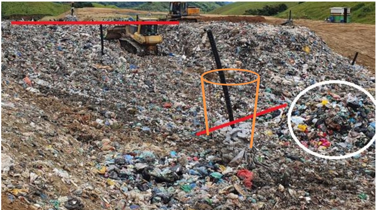
Figura 14 - Frente operacional de descarga e compactação dos resíduos. As linhas vermelhas destacam o início e o final da rampa. O círculo branco destaca os resíduos aguardando serem espalhados e compactados. Os tubos em PEAD estão envoltos por pedra rachão e tela metálica (destacada em laranja). Fonte: Autor.
