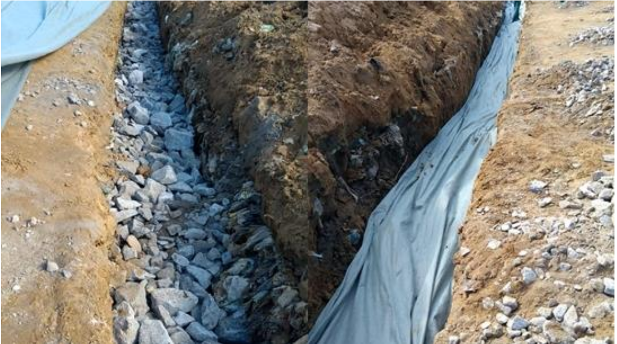
Figura 42 - Implantação do dreno de pé de talude, na primeira parte o dreno aberto com o meio drenante e após a aplicação do geotêxtil não tecido. Fonte: CTR.
