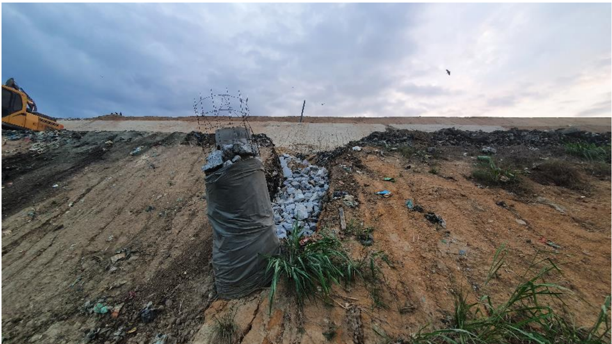
Figura 41 - Dreno de face de talude ligando um dreno de pé de talude ao dreno vertical. Fonte: CTR.
