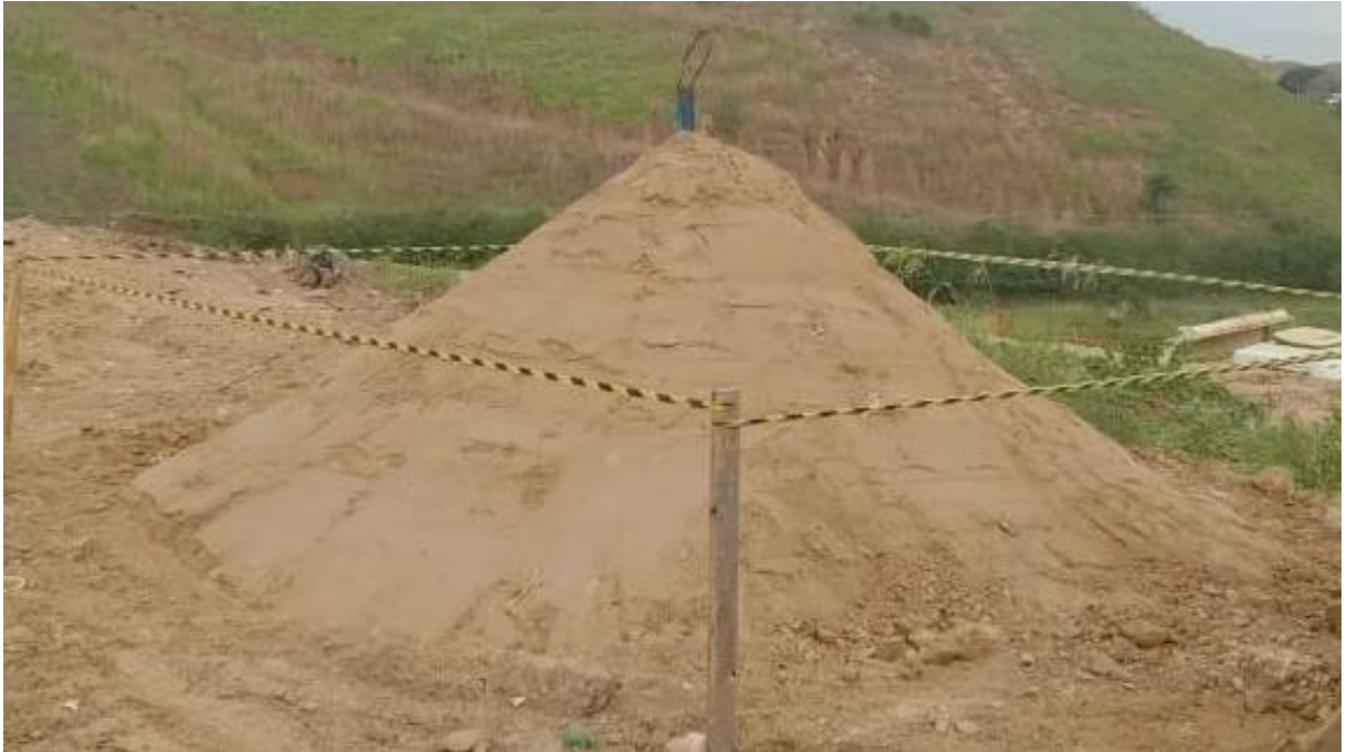
Figura 38 - "Cupinzeiro" para proteção dos drenos verticais. Fonte: CTR.
