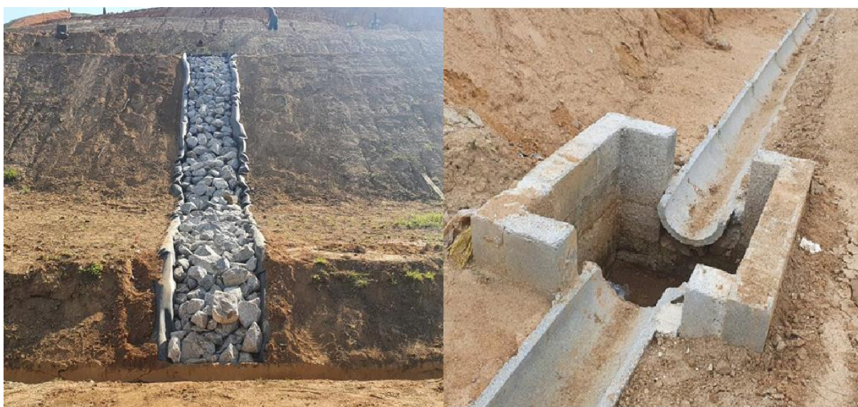
Figura 24 - Caixa de passagem de águas pluviais e colchão reno para descida d'água. Fonte: CTR.
