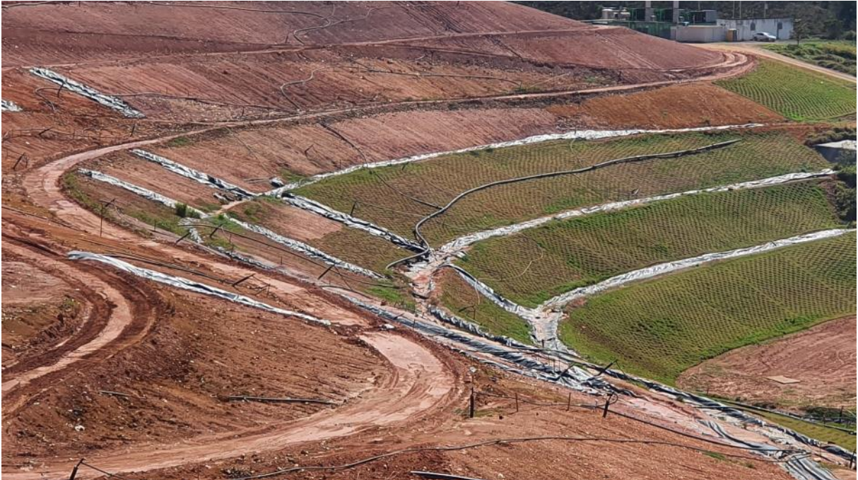
Figura 19 - Cobertura final com grama na parte inferior, representando uma camada final do aterro sanitário e camadas intermediárias nas porções superiores. Fonte: CTR.
