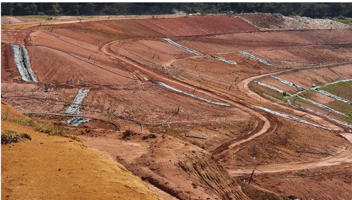
Figura 21 - Drenagem de águas pluviais com geomembrana de PEAD. Fonte: CTR.
