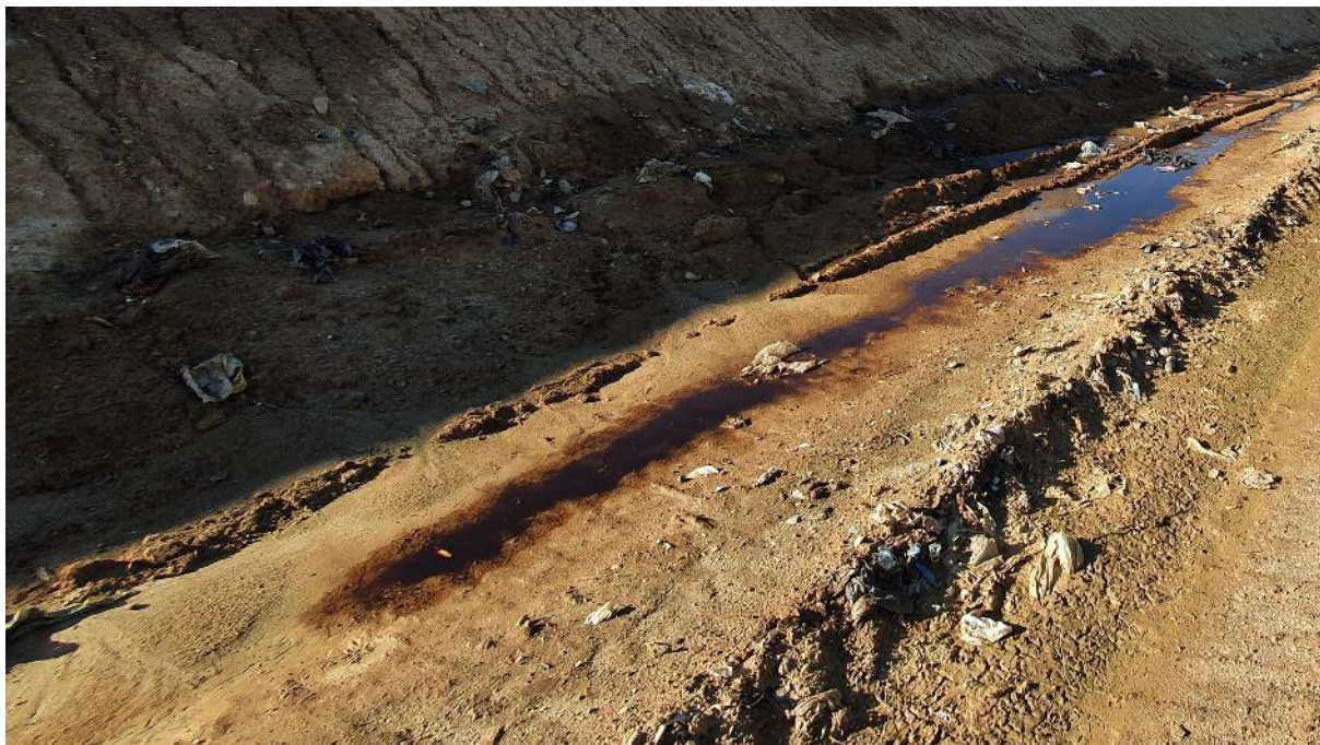
Figura 40 - Afloramento de lixiviados na berma. Fonte: CTR.
