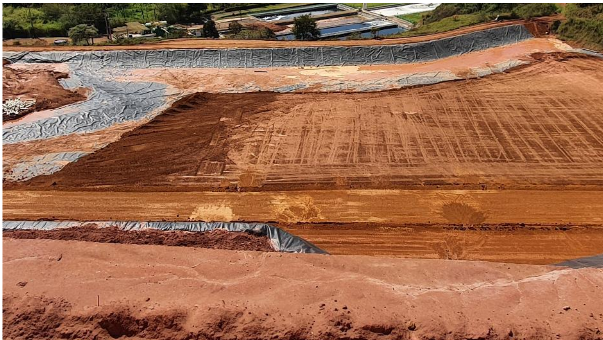
Figura 25 - Preparação e aplicação da impermeabilização de base. Fonte: CTR.
