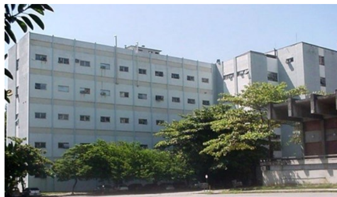
Figura 40 – Vista da fachada dos fundos do PHC
