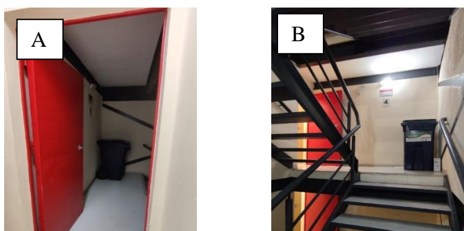
Figura 13 - Armazenamento temporário do Prédio Anexo
