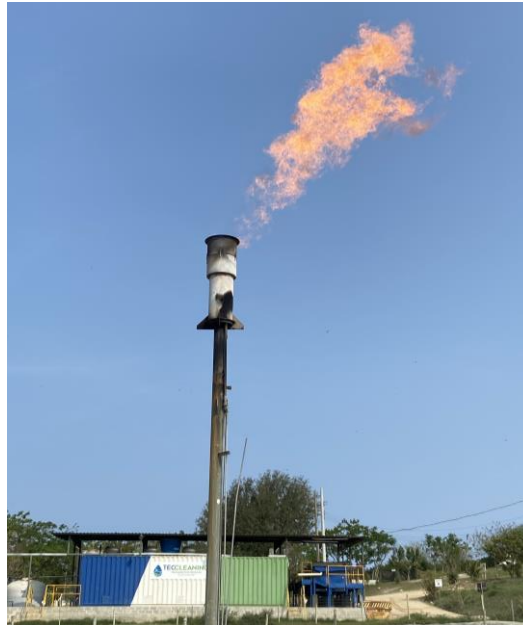
Figura 13 – Queima de gás residual no flare
