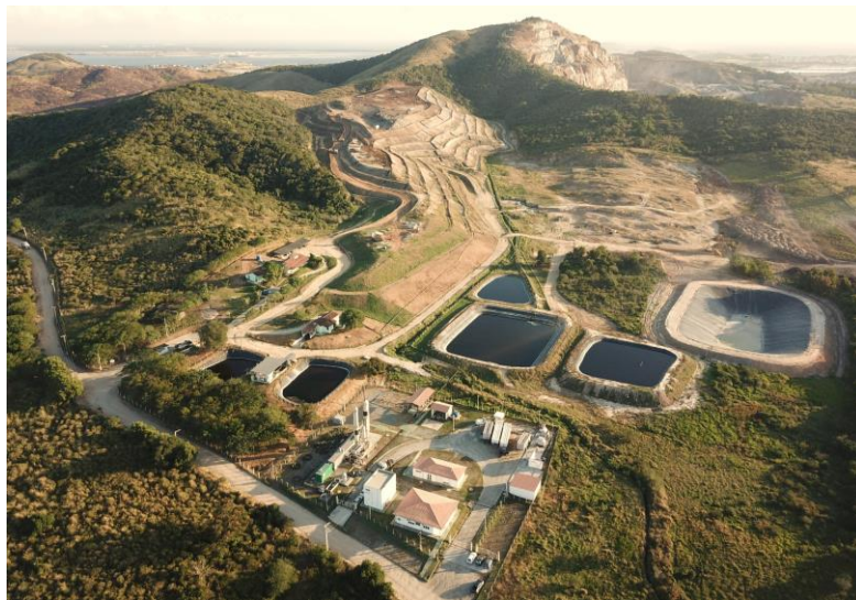
Figura 32 – Vista superior do Aterro de Dois Arcos (RJ)
