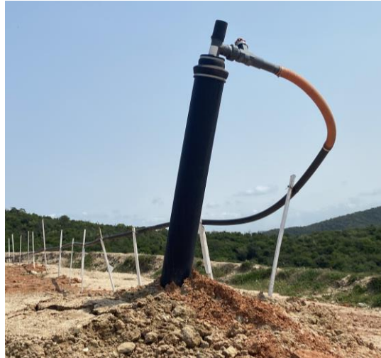
Figura 12 – Dreno vertical equipado com cabeçote regulável
