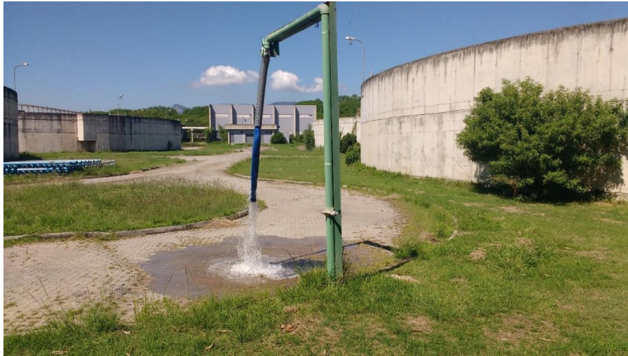
Figura 20 – Sistema de abastecimento dos caminhões pipa com água de reúso da ETE Alegria.
