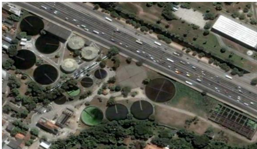
Figura 27 – Vista aérea da ETE Penha, Rio de Janeiro-RJ
