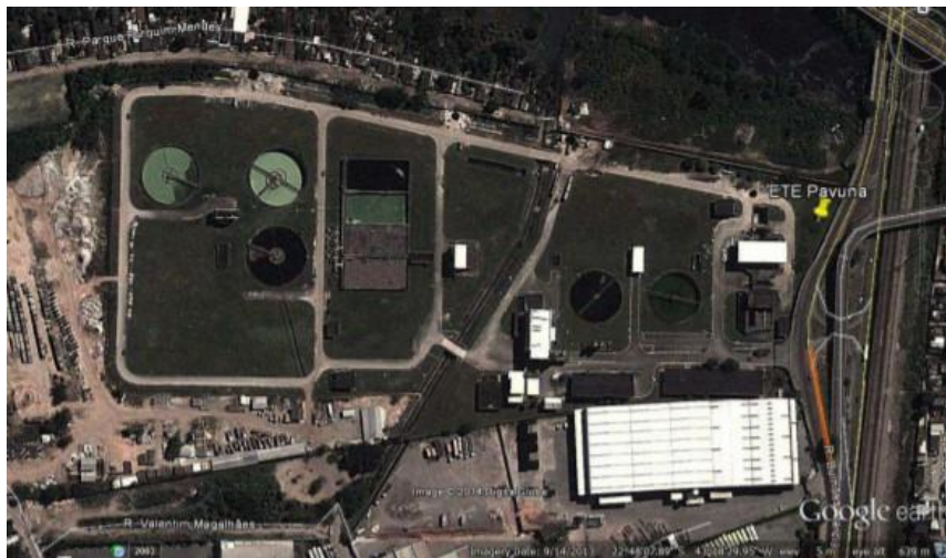
Figura 28 – Vista aérea da ETE Pavuna, Rio de Janeiro-RJ
