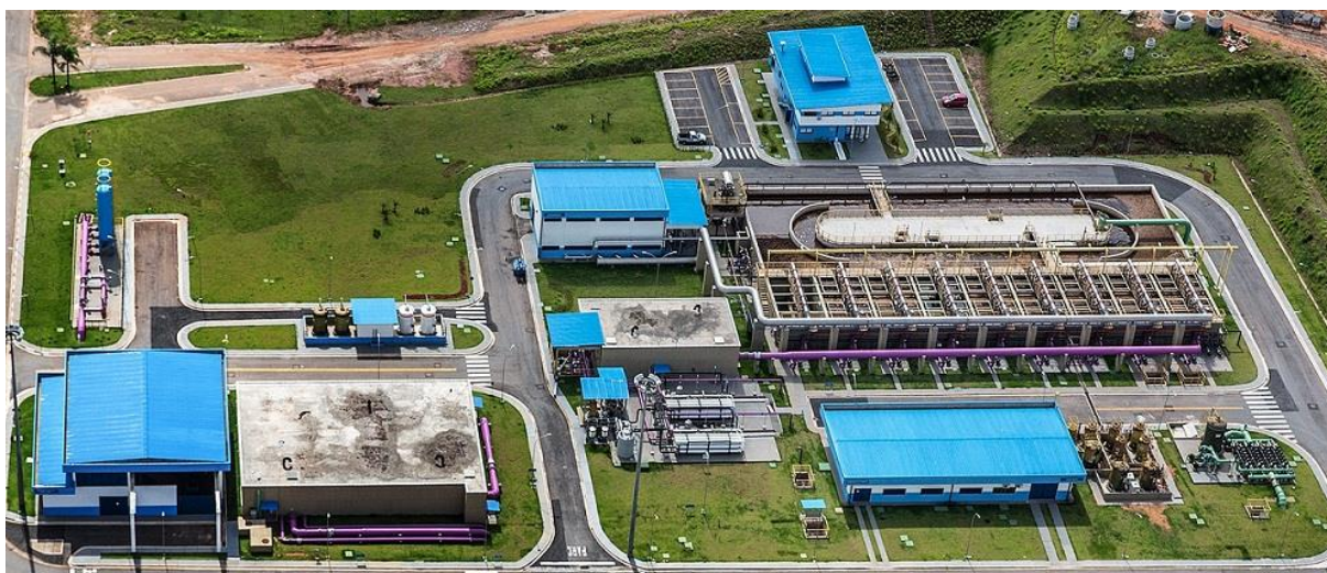
Figura 18 – Vista aérea do Aquapolo, sistema de produção de água de reúso industrial, localizado na cidade de Mauá-SP.
