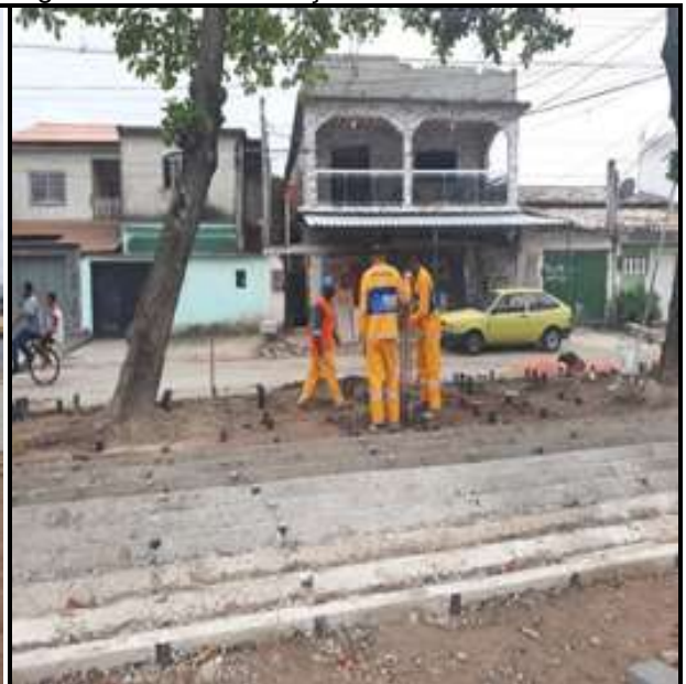
Figura 36 – Pavimentação da Pista de Caminhada
