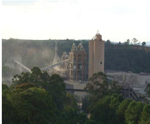
Figura 4: Emissões visíveis de material particulado.
