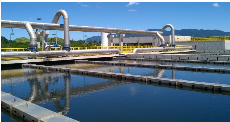
Figura 22 - Reator biológico em fase de alimentação/descarte simultâneos.
