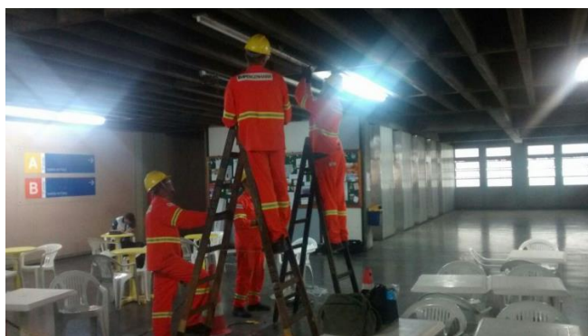
Figura 9 - Troca de lâmpadas (UERJ - Maracanã)
