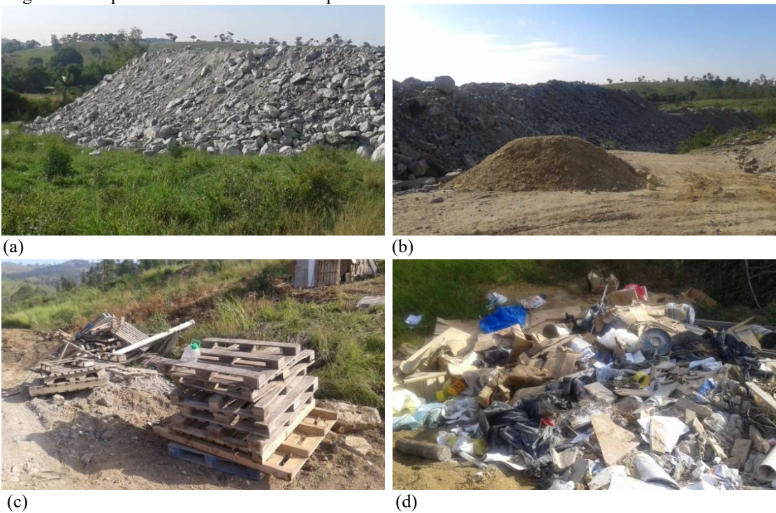
Legenda: (a) e (b) – resíduos da obra Transoceânica em Niterói, RJ; (c) – paletes de madeira; (d) – diversos tipos de resíduos misturados. Fonte: Autor, 2016.
