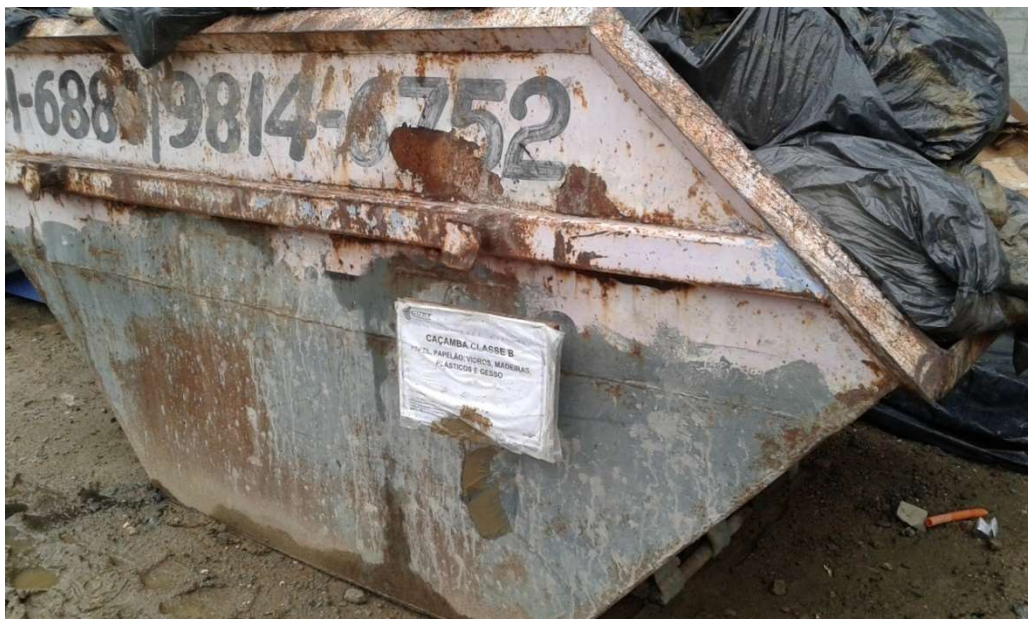
Figura 31 - Caçamba destinada à coleta de RCC classe B em um canteiro de obras.
