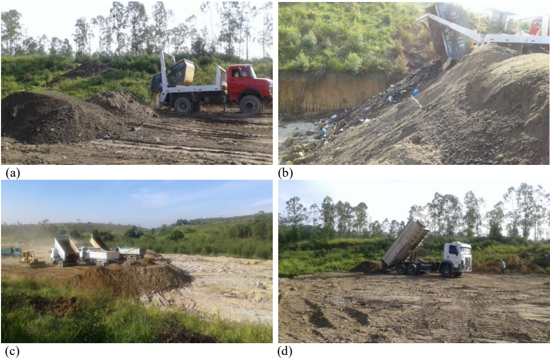
Legenda: (a) e (b) – disposição de RCC por caminhão poliguindaste; (c) e (d) – disposição de RCC por caminhões basculantes. Fonte: Autor, 2016.
