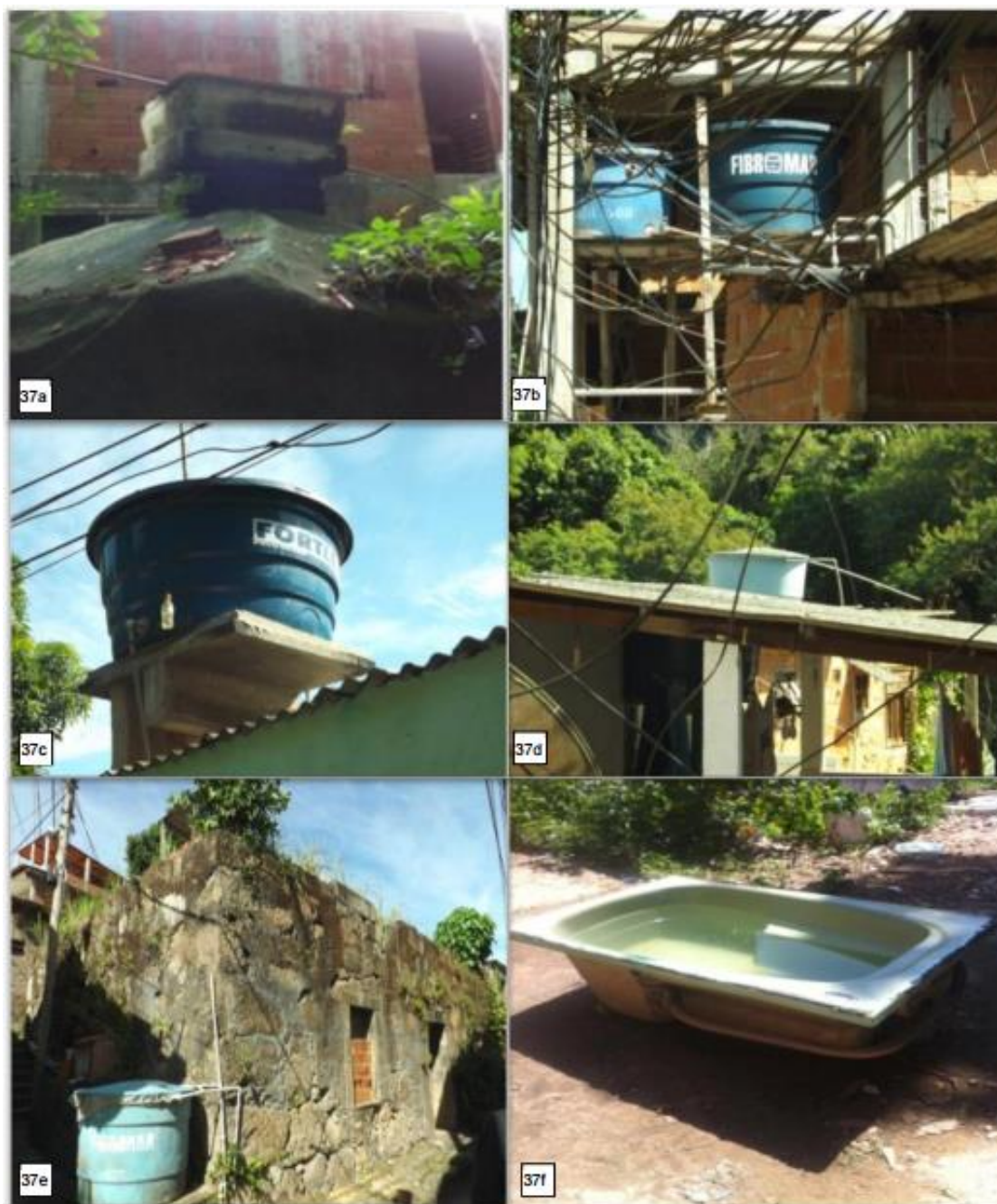
Figura 37- Armazenamento da água. 37a- caixa-d'água sobre a rocha; 37b- caixa-d'água na laje; 37c- caixa-d'água sobre a casa; 37d- caixa-d'água sobre a casa; 37e- caixa-d'água junto ao solo, próxima a parede de uma construção que é considerada uma antiga senzala; 37f- banheira reutilizada para armazenar água.
