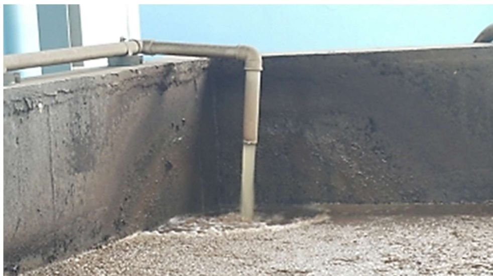
Figura 19 - Afluente sanitário e industrial
