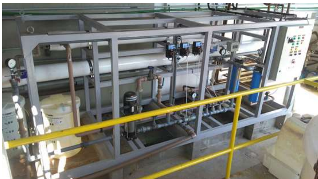
Figura 8 – Sistema de Osmose Inversa para reuso dos efluentes da indústria farmacêutica
