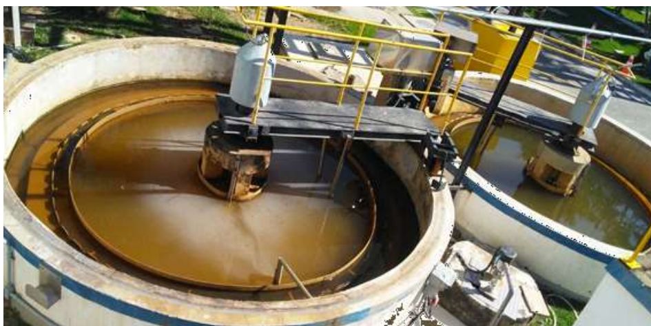
Figura 6 - Decantação final dos efluentes oriundos do reator aeróbio de uma indústria farmacêutica.
