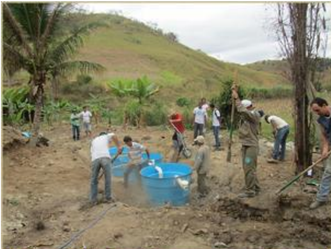
Figura 33 - Instalação da fossa séptica biodigestora. Fonte: Instituto Terra, 2015.
