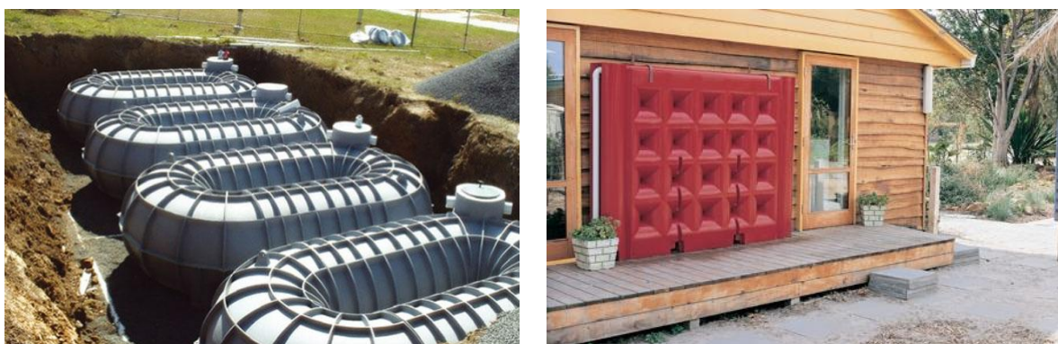
Figura 14: Exemplos de reservatórios de água da chuva subterrâneos e visíveis. (Fonte: Harvesting Brasil)
