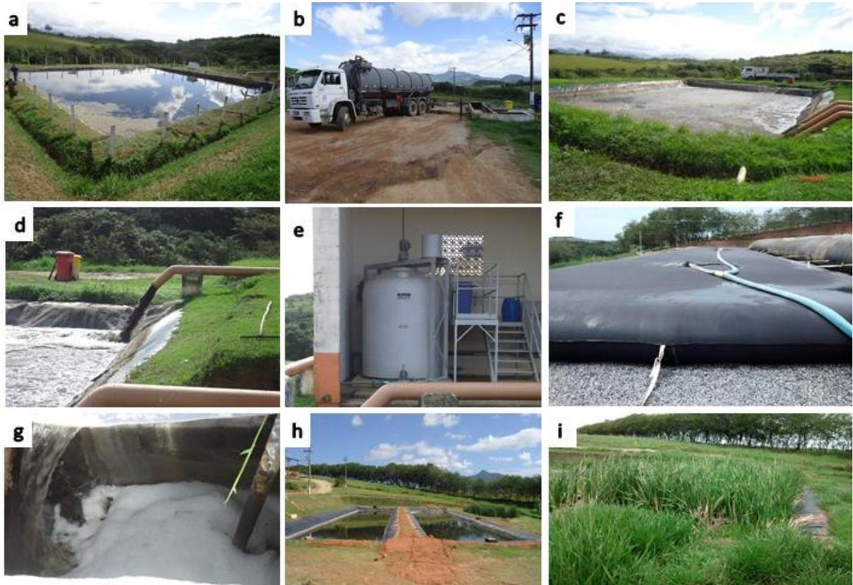
Legenda: a- Lagoa de lixiviado; b- caminhão limpa fossa descarregando; c- lagoa de mistura de lodo de fossa e lixiviado; d- homogeneização d lago de mistura; e- tanque de polímero; f- geobags; g- caixa de saída dos geobags; h- lagoas de estabilização; i- wetland.
