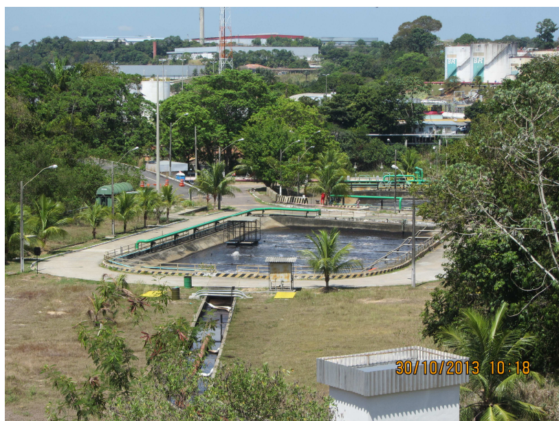
Figura 2.16. – Lagoa Aerada e Biodrum em uma refinaria brasileira.
