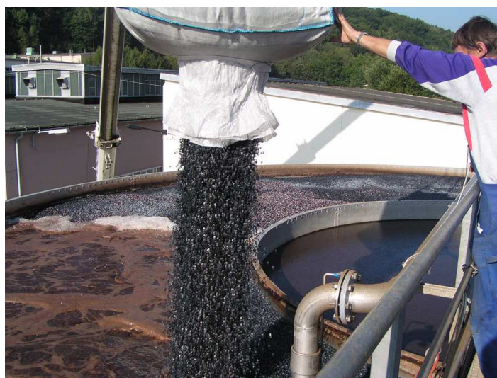
Figura 2.24. – Enchimento de um reator MBBR. Fonte: BIODOS (2013).
