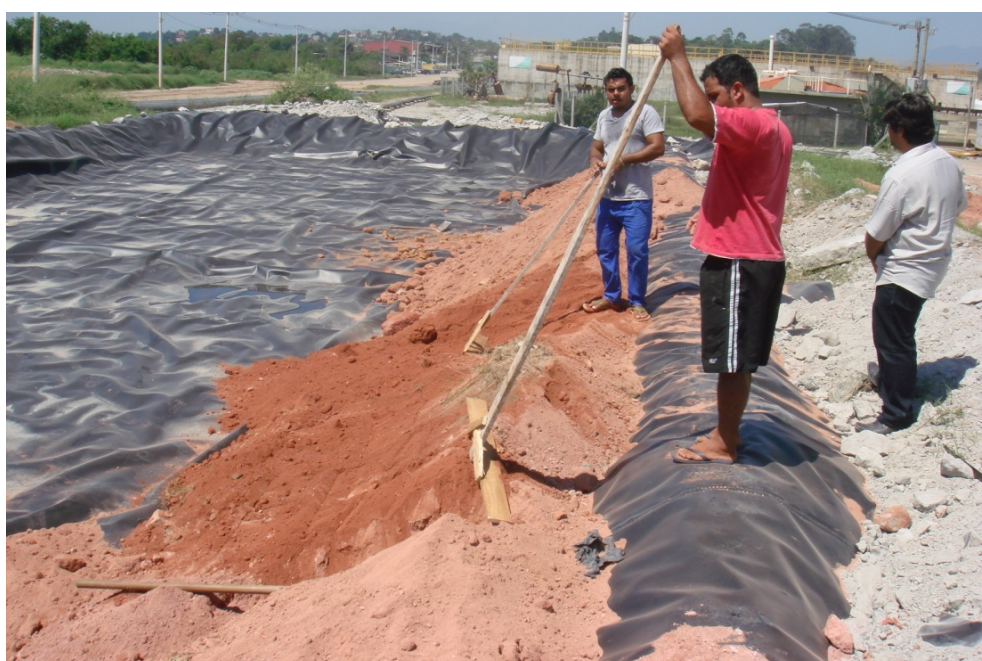
Figura 18: Lançamento da camada de argila.
