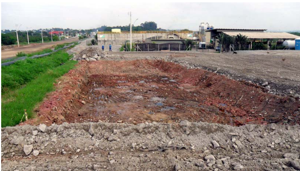
Figura 10: Vista do início da construção: escavação
