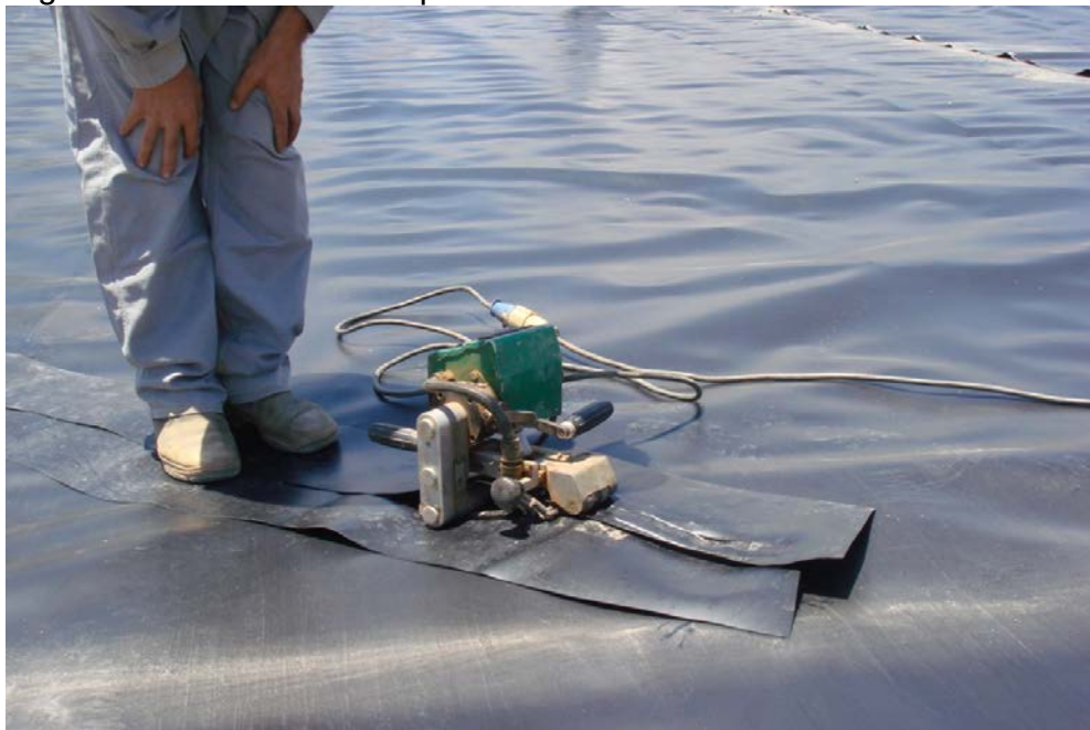
Figura 15: Posicionando a geomembrana no wetland.
