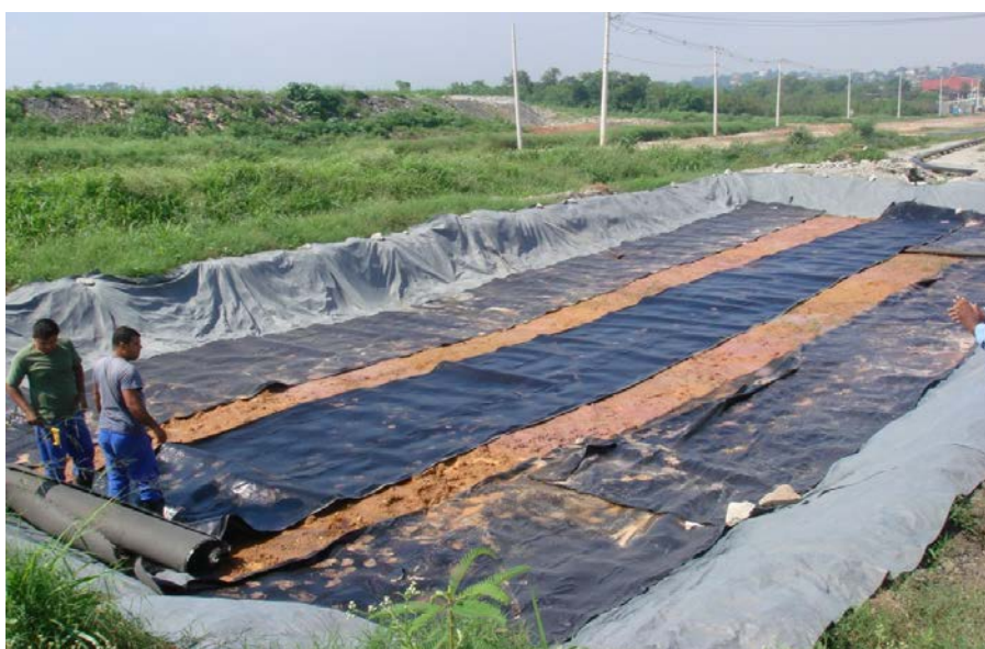
Figura 12: Instalando uma proteção para manta de PEAD
