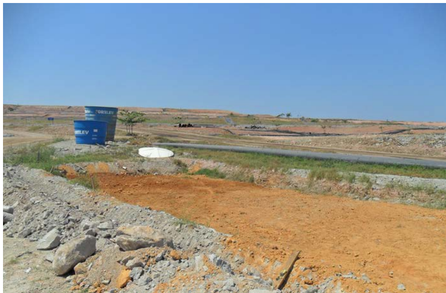
Figura 11: Nivelamento da fundação
