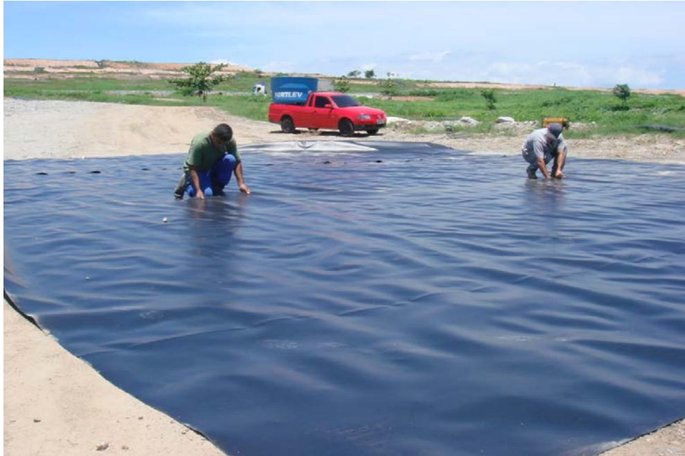
Figura 13: Posicionando a geomembrana para a soldagem
