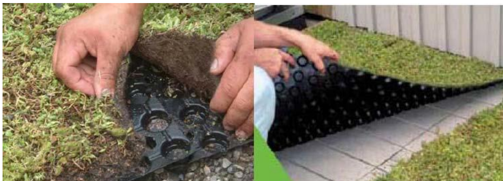
Figura 8- Estrutura modular tipo “tapete” para desenvolvimento de telhado verde.
