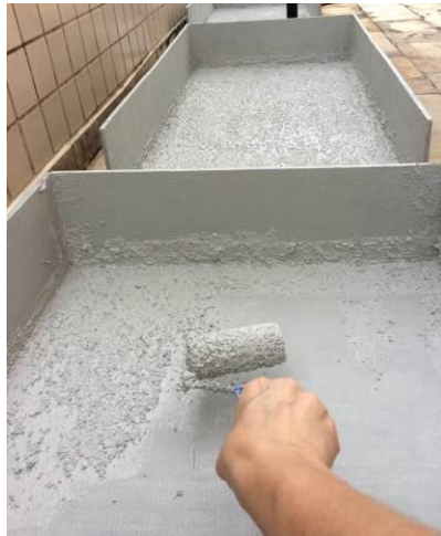
Figura 31 – Foto da aplicação da primeira demão do impermeabilizante Icooper Strong..
