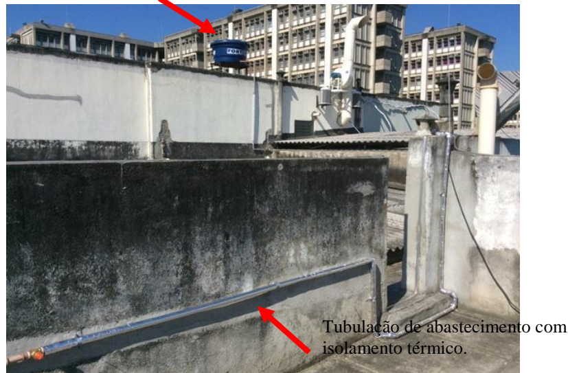
Figura 23 - Foto do reservatório de água, de 500L para utilização nos experimentos.
