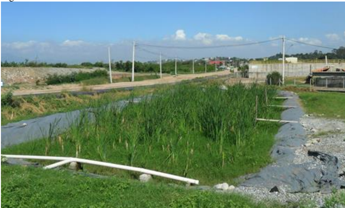
Figura 6 - Wetland construído no Aterro.
