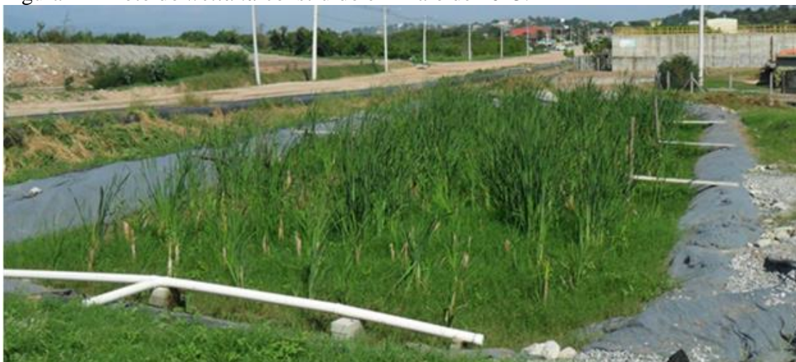
Figura 12 - Foto do wetland construído em maio de 2013.
