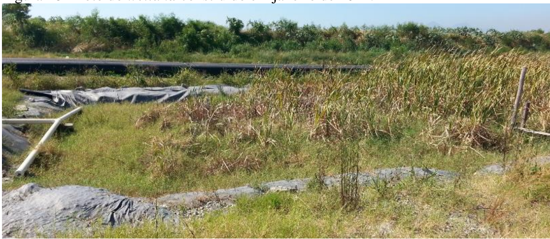
Figura 18 - Foto do wetland construído em janeiro de 2014.
