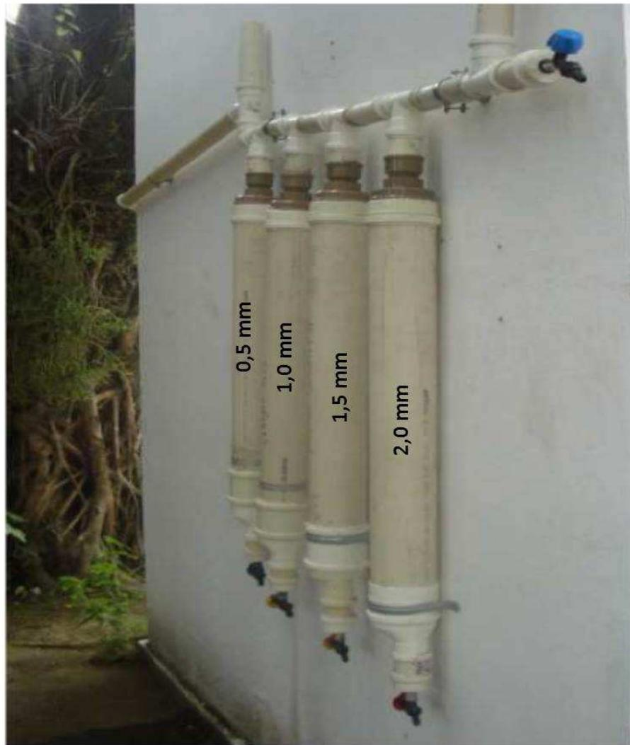
Figura 8: Coletor de Águas de Primeiro descarte, com diferentes volumes de descarte inicial. (Fonte: Peixe, 2012)
