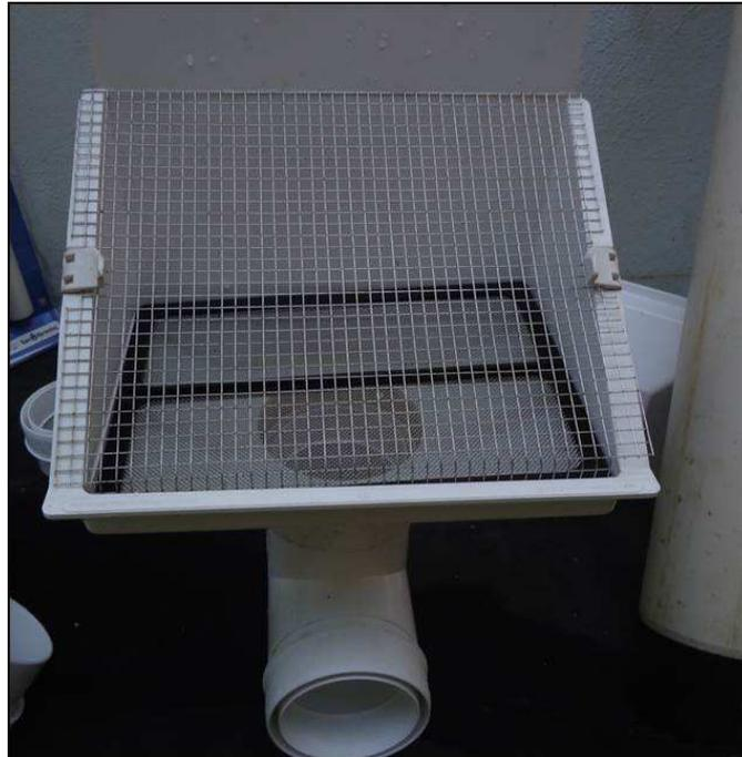
Figura 16: Tela de filtragem para separação de material grosseiro.
