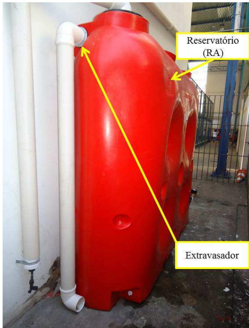
Figura 18: Reservatório de Armazenamento (RA).
