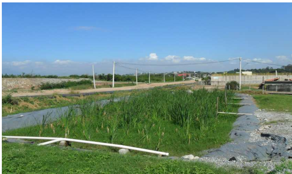
Figura 8 - Foto do wetland construído, em escala piloto, no Aterro Controlado Metropolitano de Jardim Gramacho.
