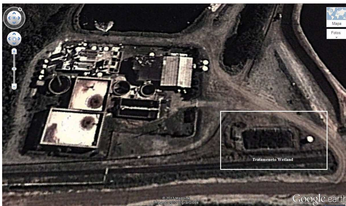
Figura 6 - Foto aérea da Estação de tratamento de Lixiviado do Aterro Controlado Metropolitano de Jardim Gramacho, em ênfase área de construção do wetland .
