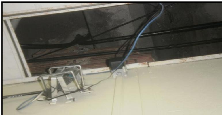
Figura 17: detalhe de ausência de forro no teto, com exposição de instalações elétricas – 4º pavimento.
