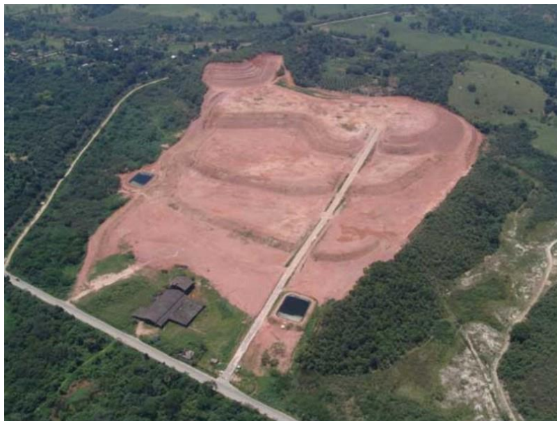
Figura 5 - Situação Lixão da Marambaia depois da recuperação ambiental da área. Fonte: CTR Nova Iguaçu
