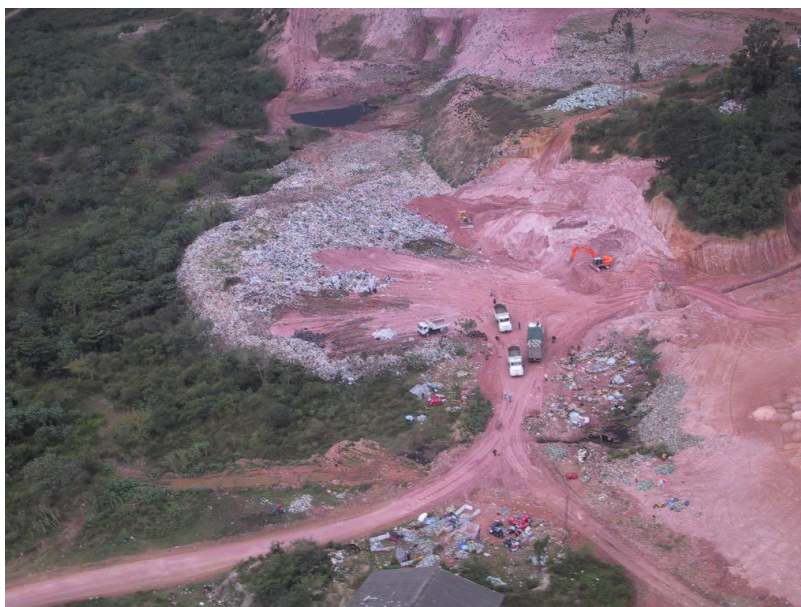
Figura 4 - Situação do Lixão da Marambaia antes da desativação.
