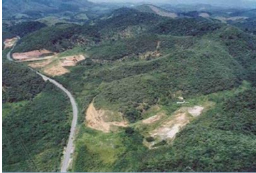
Figura 6 - Vista aérea da área selecionada para a implantação do Aterro Nova Iguaçu antes do início das operações de recebimento de resíduos. Fonte: CTR Nova Iguaçu
