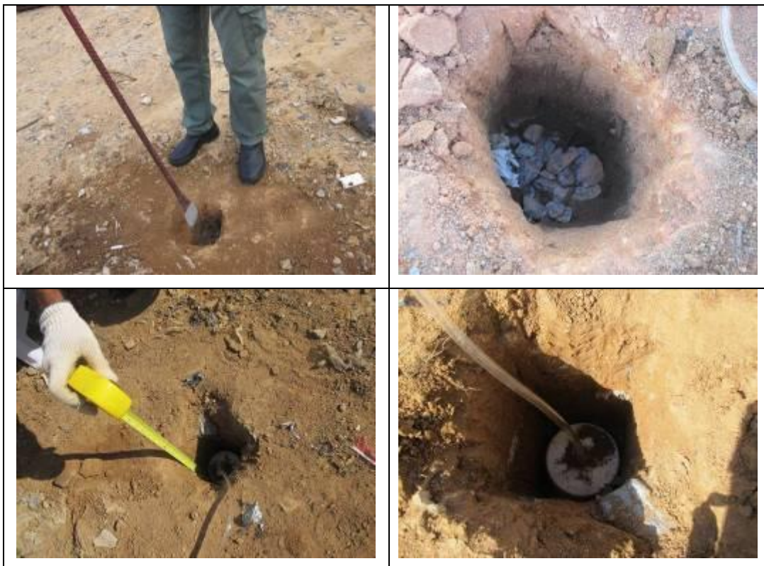
Figura 28 – Detalhe da instalação do dispositivo de DMPC na camada de cobertura.
