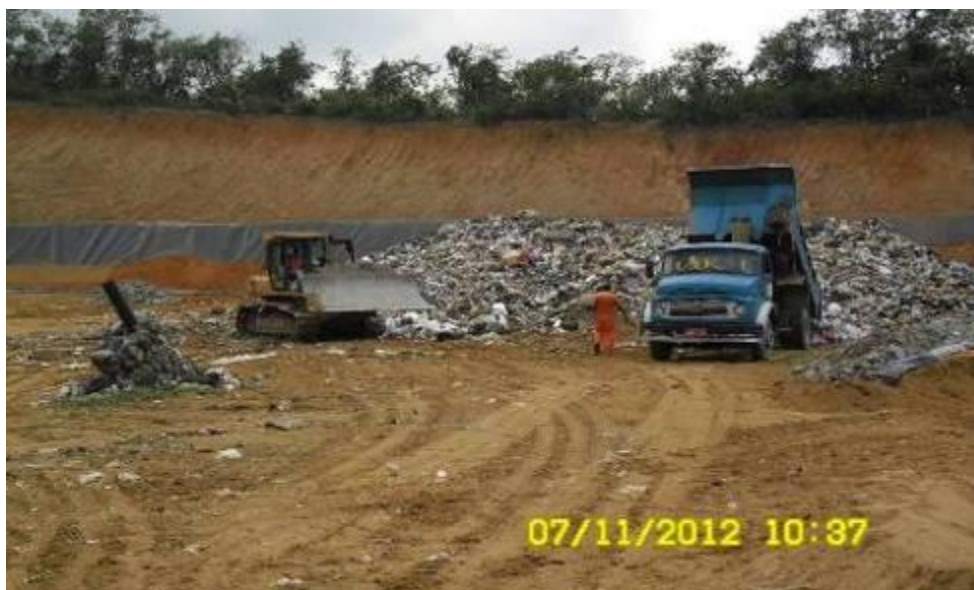
Figura 8 - Recebimento, espalhamento e compactação de resíduos (Vale 4 – Cota 97). Fonte: CTR Nova Iguaçu
