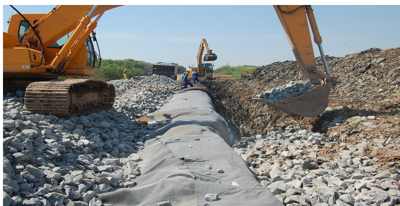
Figura 2.6: Finalização da construção da drenagem lateral. Fonte: BRAILE, 2013.
