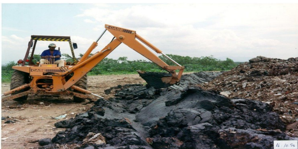
Figura 2.4: Construção da barreira lateral com argila local no ano de 1996. Fonte: COMLURB
