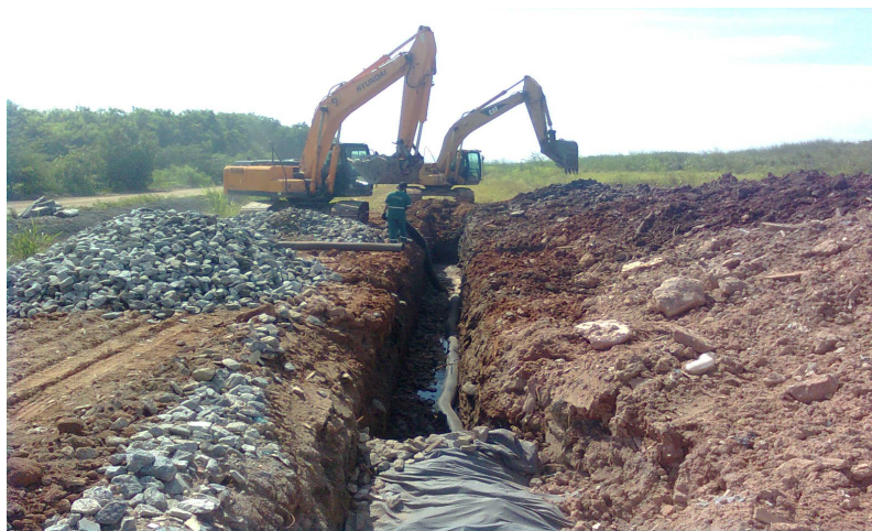
Figura 2.5: Construção da drenagem lateral. Fonte: BRAILE, 2013.
