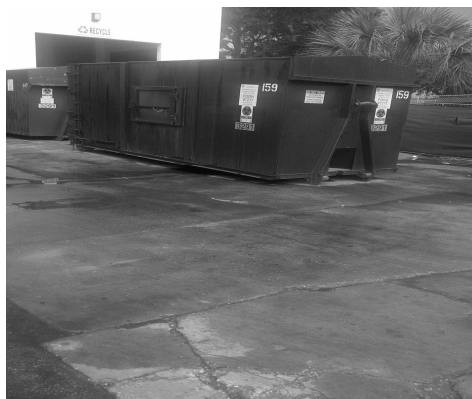
Figura 36 – Armazenagem de grande gerador de RSS Fonte: Autor, 2012
