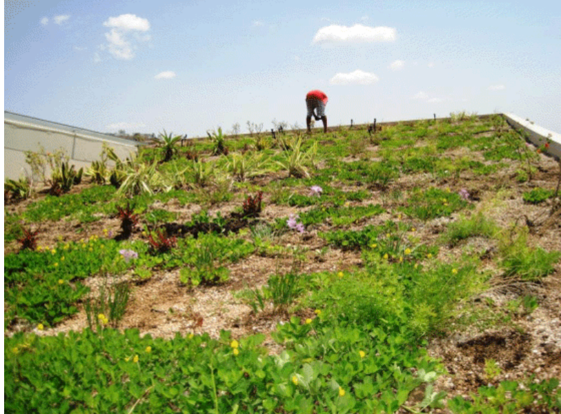
Figura 6. Telhado verde com arachis pinto em inclinações de até 12% instalado em residência na Costa Rica. Fonte: O'CONNOR (2010).
