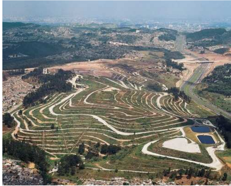
Figura 4: Visão aérea do aterro sanitário Bandeirantes em São Paulo. Fonte: Coelho, 2008.
