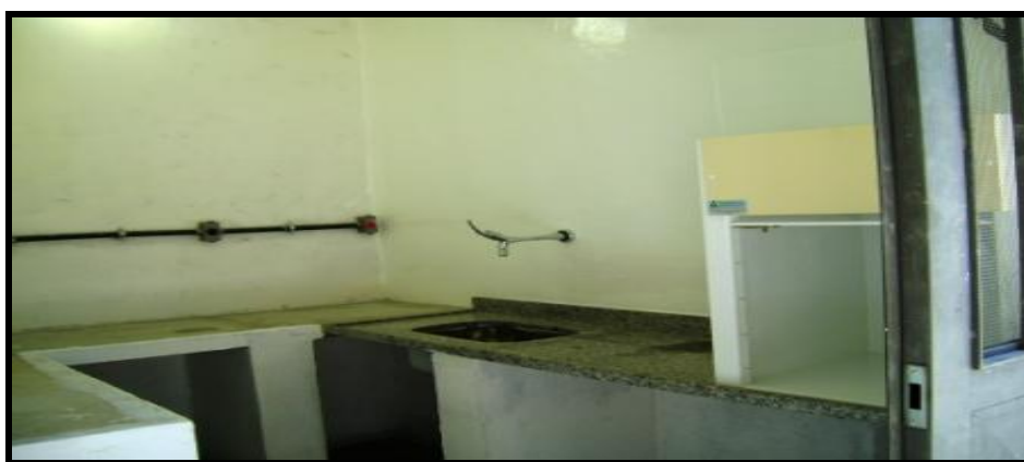
Figura 22: Sala de Caracterização de Resíduos Químicos ao lado do PHLC
