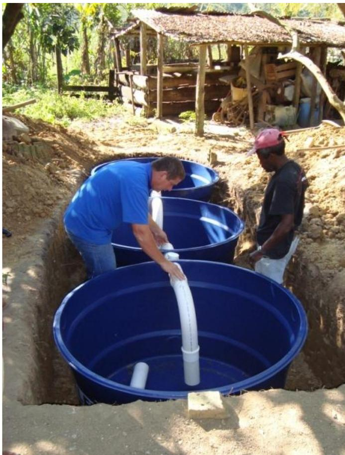
Figura 12 - Instalação de Fossas Septicas na microbacia Cambucaes.
