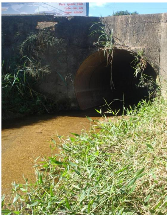
Figura 18 - Córrego atravessando a BR101 através de manilhas.
