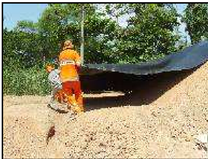
Figura 30 – Estiramento da manta sobre a superfície das células
