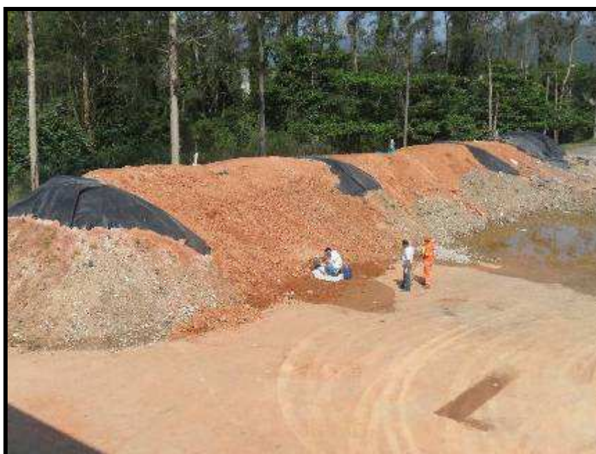
Figura 23 – Panorâmica das células após finalização
