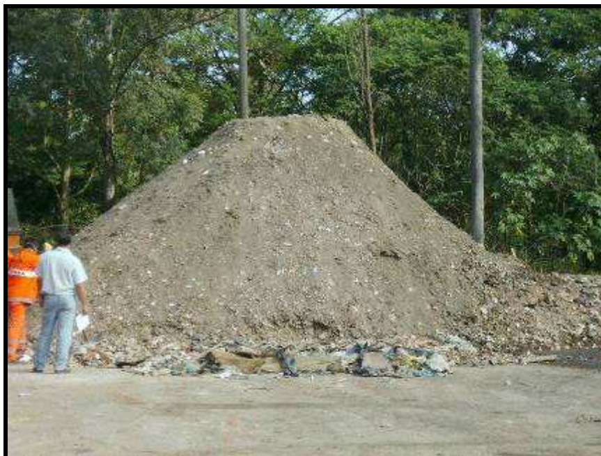
Figura 9 – Formação do talude e das bermas
