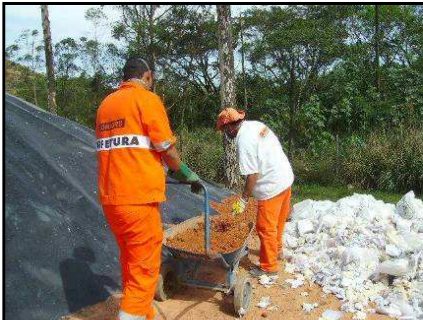
Figura 22 – Colocação de argila nas laterais da célula
