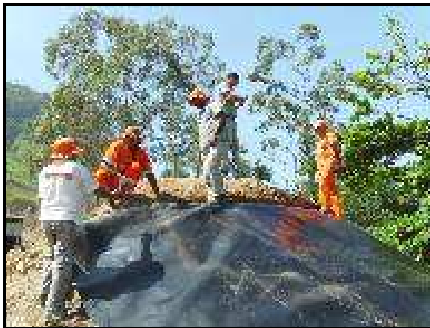
Figura 31 – Ancoramento da manta com a argila
