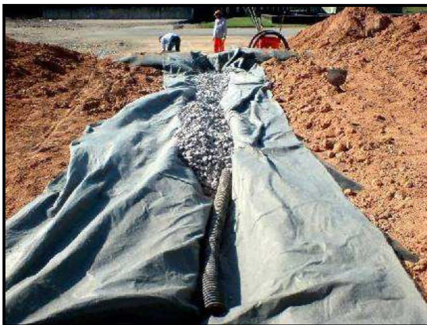
Figura 17 – Finalização das valetas com depósito das britas
