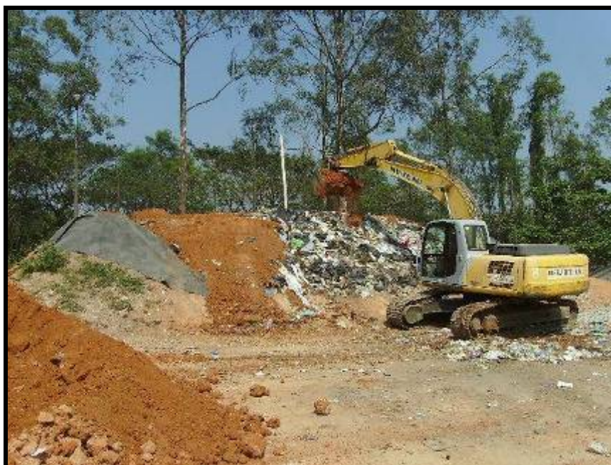
Figura 21 – Operação com a retro-escavadeira
