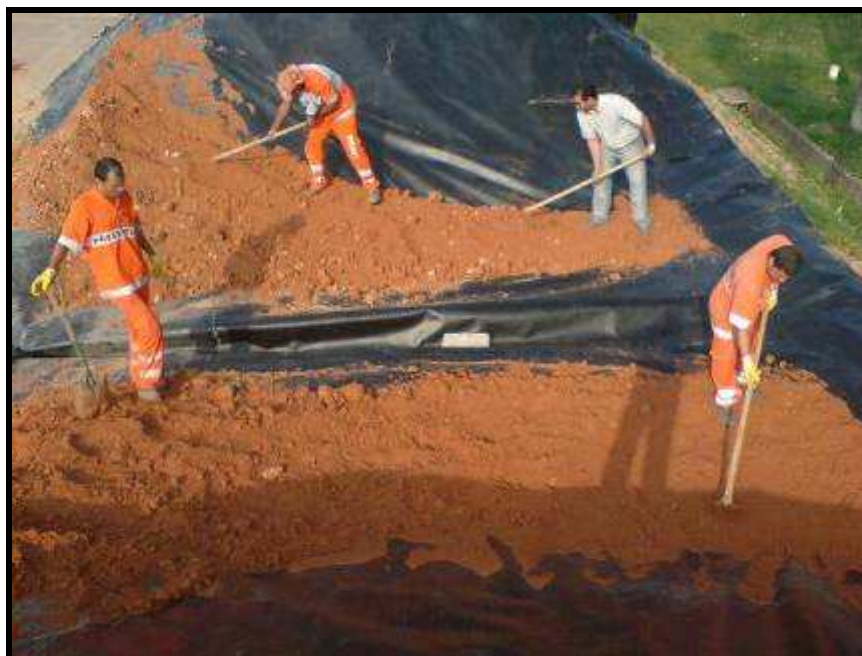
Figura 14 – Cobertura da manta PEAD com argila
