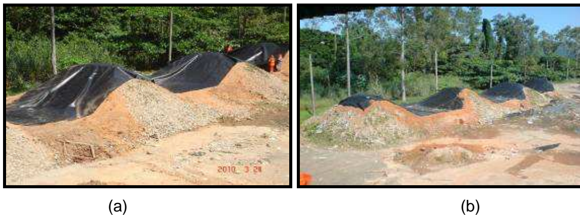
Figura 13 (a) e(b) – Diferentes vistas da colocação da manta de PEAD sobre as células
