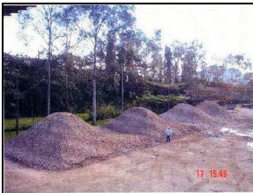
Figura 12 - Vista panorâmica das células. - Preparação para recebimento da manta
