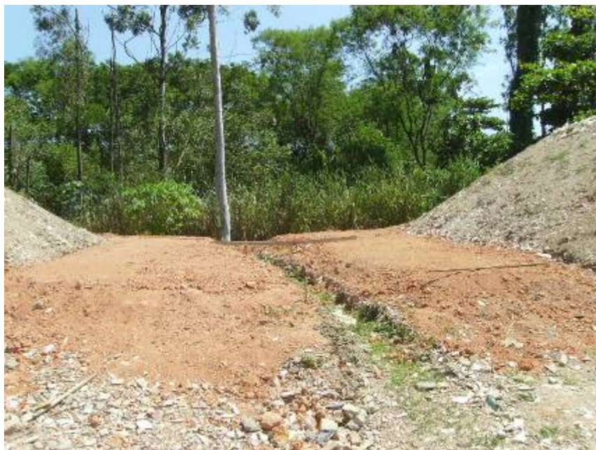
Figura 11 - Acomodação dos resíduos de construção civil sob a forma de pirâmides
