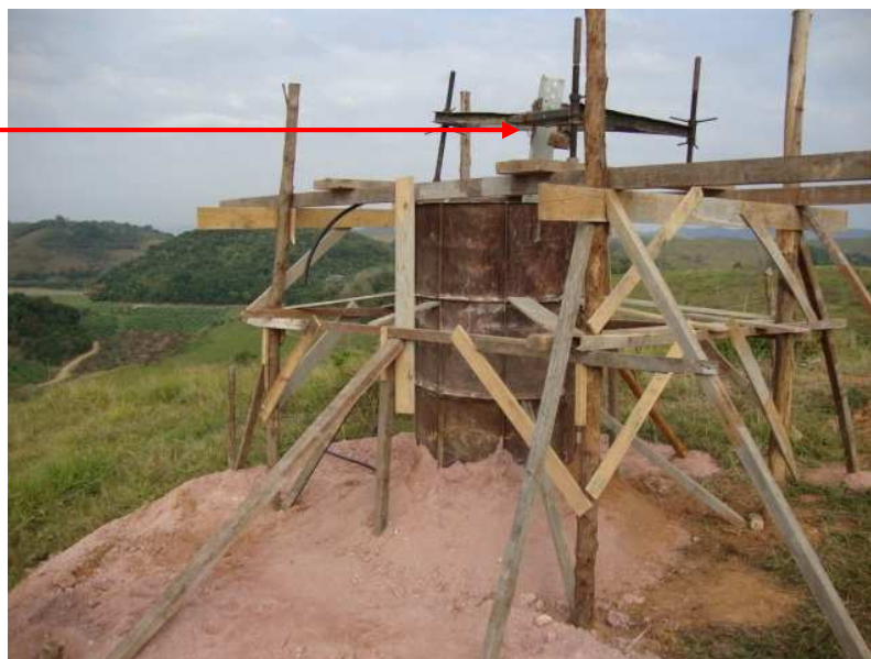
Fotografia 4: Ilustração de um pé de torre preparado para a concretagem
