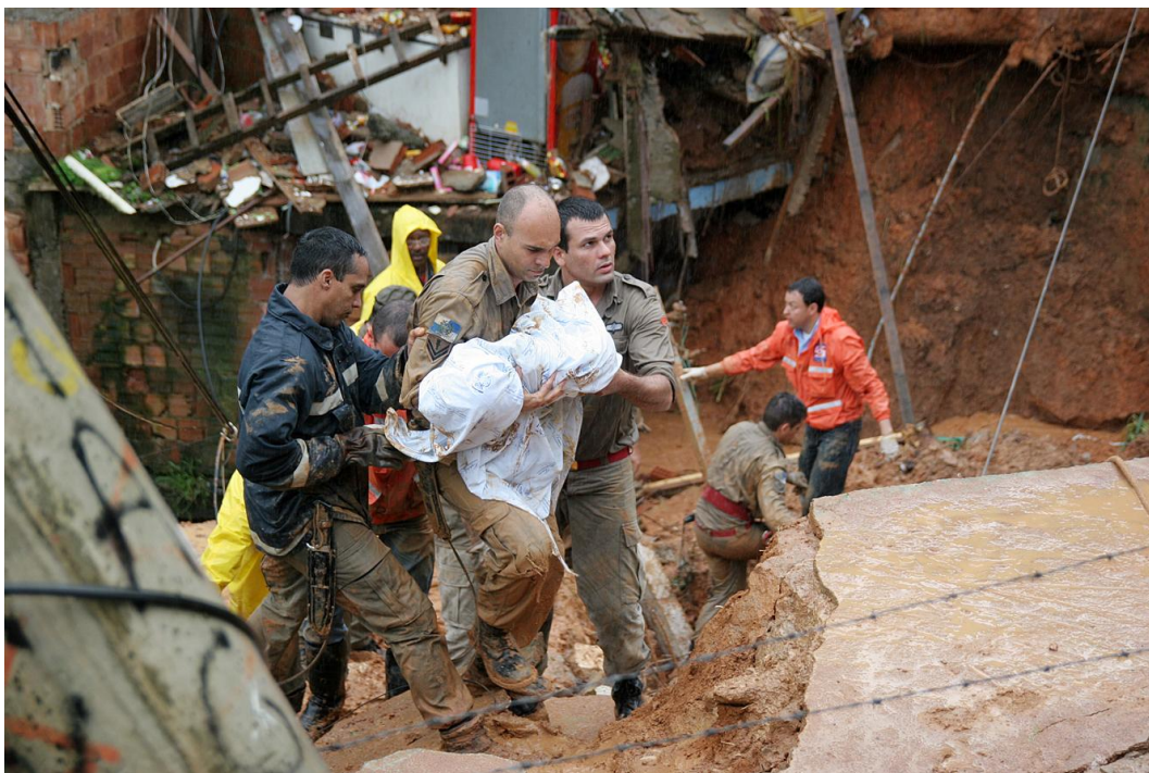
Figura 4 - Imagem cedida pela Coordenadoria Municipal de Defesa Civil de Petrópolis – RJ
