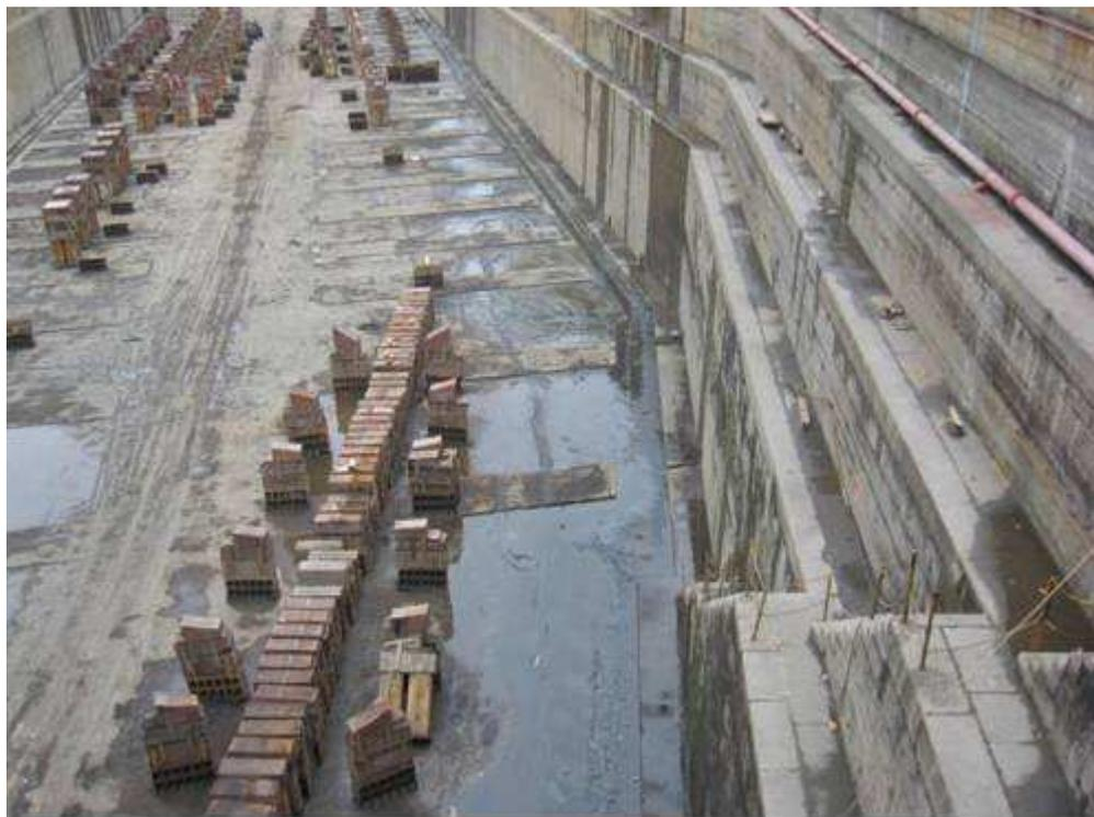
Figura 30 - Lamas com contaminantes no fundo do dique. Apresenta resíduos de tintas, abrasivos gastos, óleos e graxas, anodos de sacrifício, lixos, metais pesados e outros resíduos.
