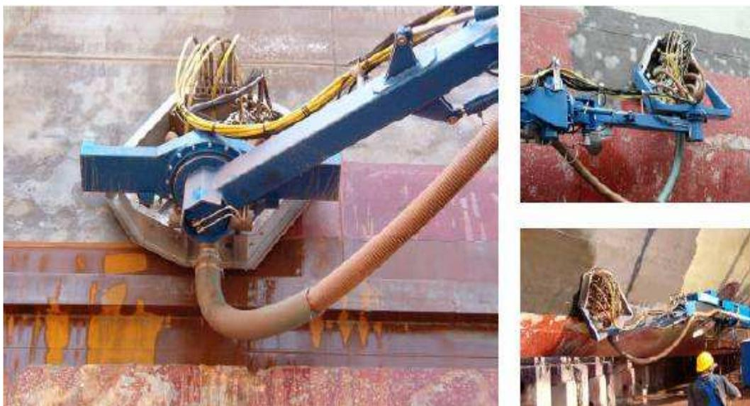
Figura 27 - Navio Porta Container, Holanda 2003, sendo jateado por sistema robotizado, equipamento Dockmaster 3000.
