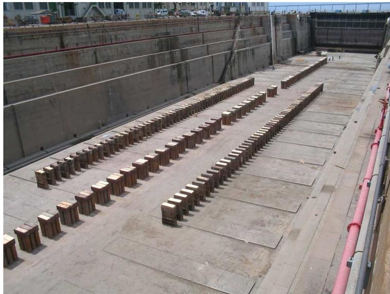
Figura 19 - Visão dos picadeiros, preparados para a docagem da embarcação. Ao final do dique, a porta batel, que serve de limite para a Baía de Guanabara. Fonte: Arsenal de Marinha, arquivo do AMRJ 246 (2008).
