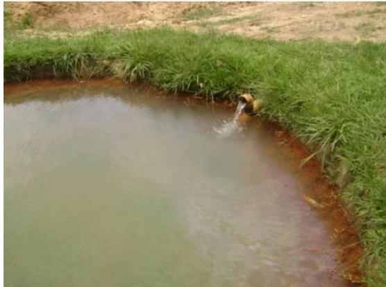
Figura 135 – Lagoa de Acumulação da drenagem - CTR Nova Iguaçu
