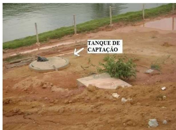
Figura 84 - Tanque de Captação do Chorume – CTR Macaé
