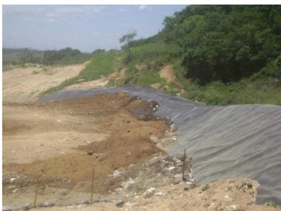
Figura 106 – Camada de Proteção da manta no Talude - Aterro de São Pedro da Aldeia
