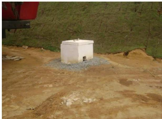
Figura 85 – Poço de Monitoramento de Águas Subterrâneas – CTR Macaé
