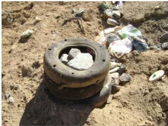
Figura 26 – Extremidade do Dreno Vertical – Aterro Sanitário de Pirai
