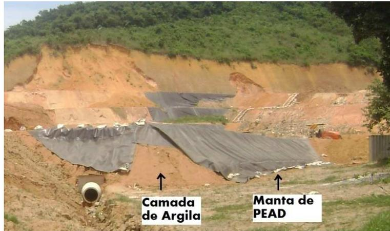
Figura 133 – Impermeabilização da Base - CTR Nova Iguaçu
