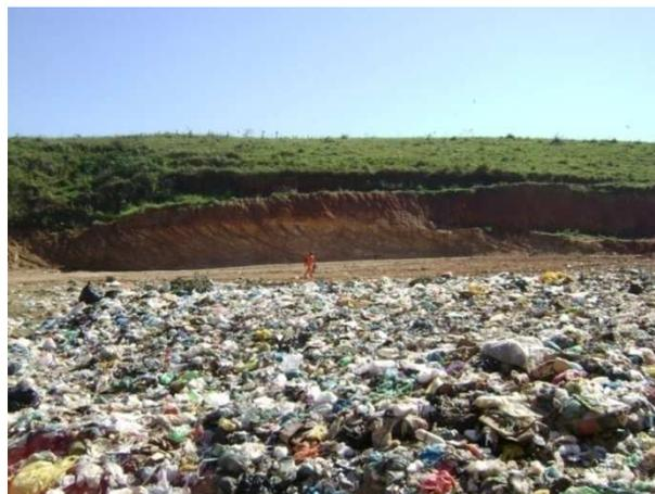
Figura 12 – Resíduos Espalhados para Nivelamento da Área – Aterro Sanitário de Pirai
