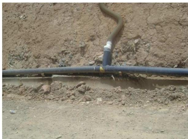
Figura 138 – Canalização Externa do Dreno Horizontal de Gás - CTR Nova Iguaçu
