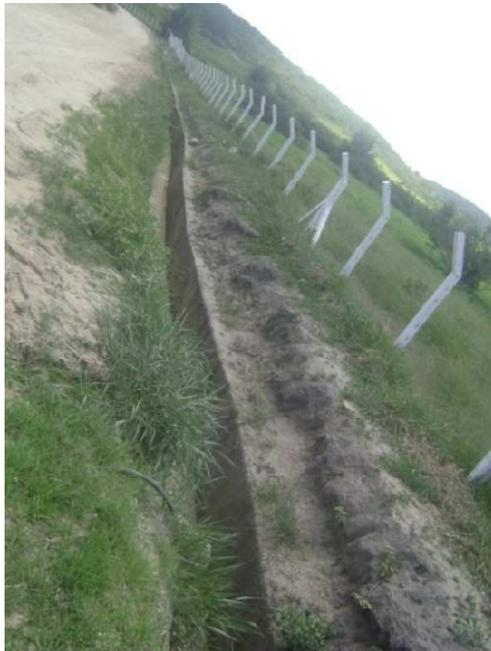
Figura 111 – Drenagem Pluvial – Aterro de São Pedro da Aldeia
