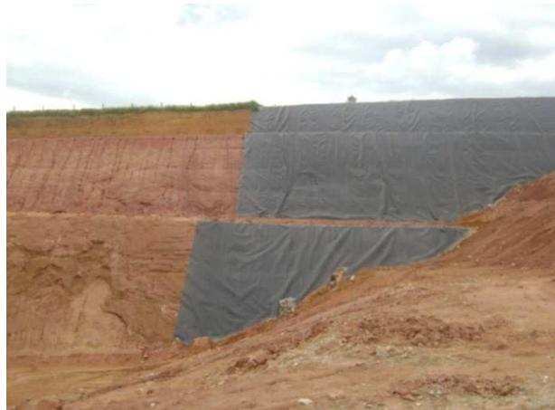
Figura 74 - Impermeabilização dos taludes - CTR Macaé
