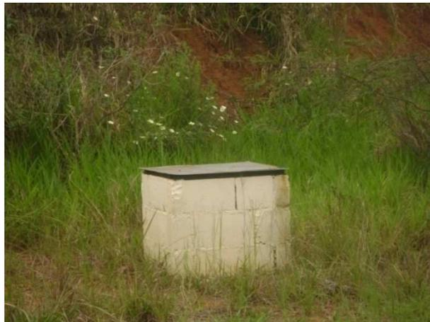
Figura 59 – Poço de Monitoramento de Águas Subterrâneas – CTR Rio das Ostras
