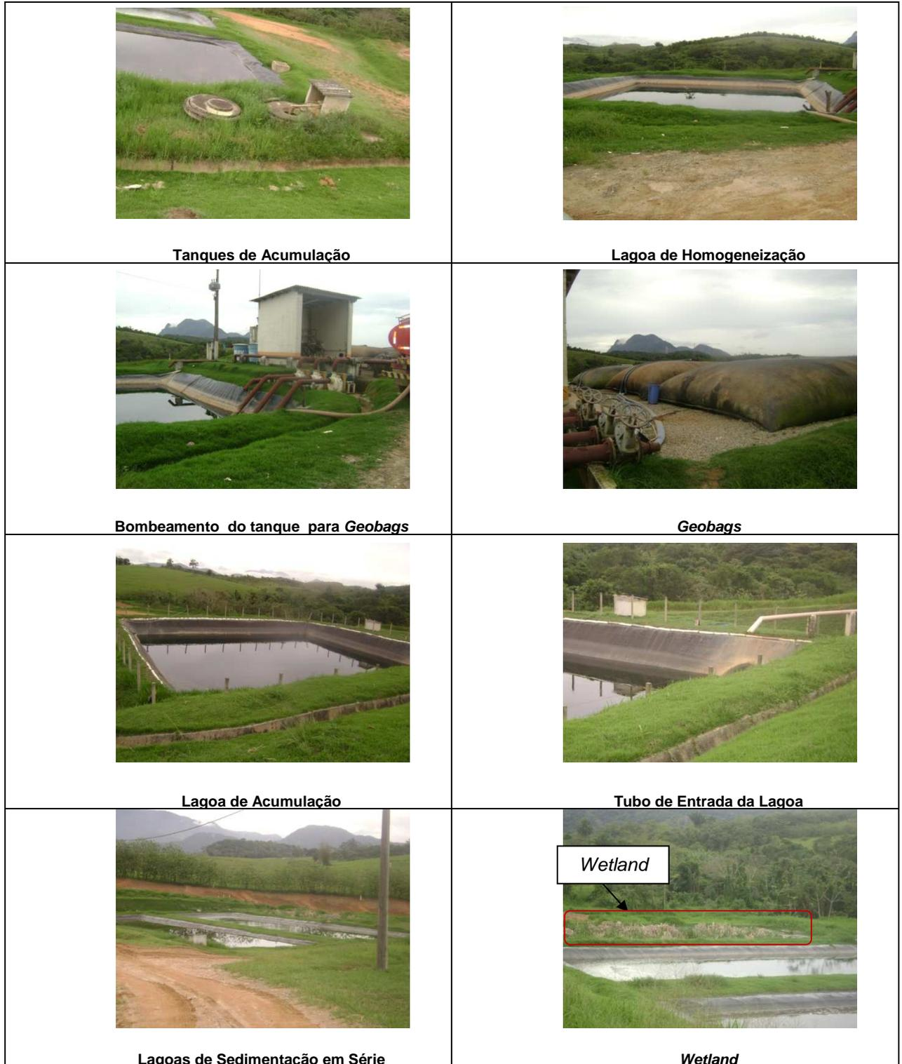
Figura 58 – Detalhes do Sistema de Tratamento de Chorume – CTR Rio das Ostras
