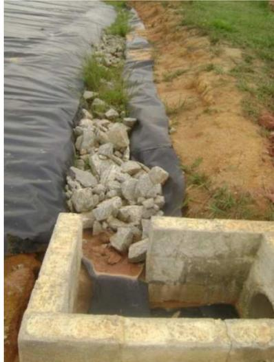
Figura 80 - Drenagem Executada na Ancoragem - CTR Macaé
