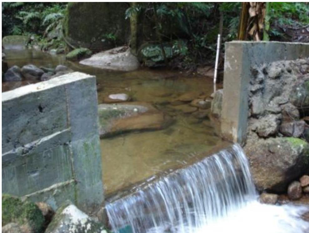
**Figura 3.17** – Vertedouro no ponto 8 onde está instalado a sonda de monitoramento de nível do projeto HIDROCIDADES.
