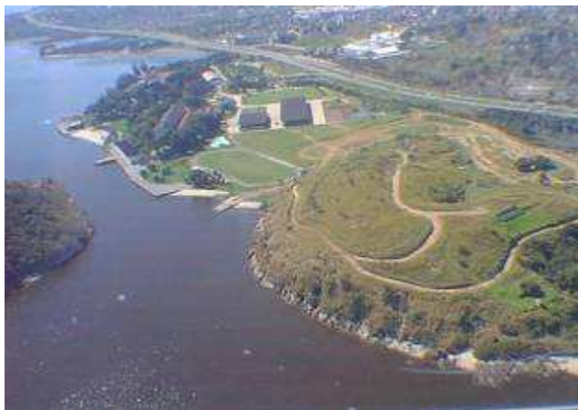
Figura 29 - O Complexo com a Rodovia BR101 em segundo plano.
