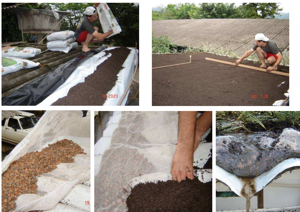
Figura 3.12 - Instalação do filme plástico e colocação do substrato; detalhe da confecção do dreno
