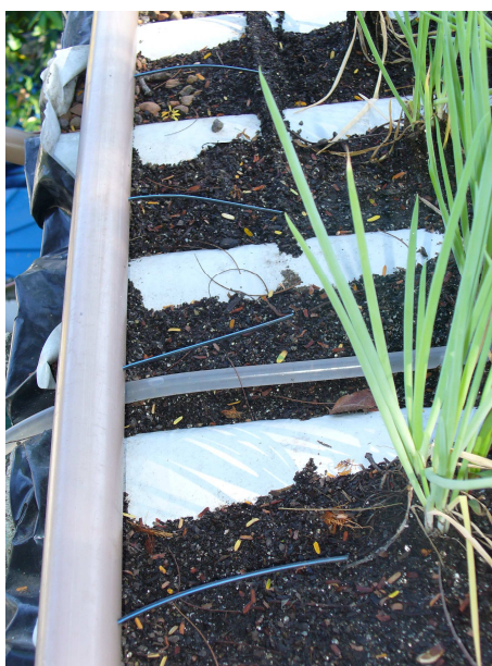
Figura 3.10 - Sistema de irrigação por gravidade com microtubos utilizado para irrigar cada canaleta da telha de fibrocimento, correspondente a linha de plantio da cultura, sobre o telhado verde.
