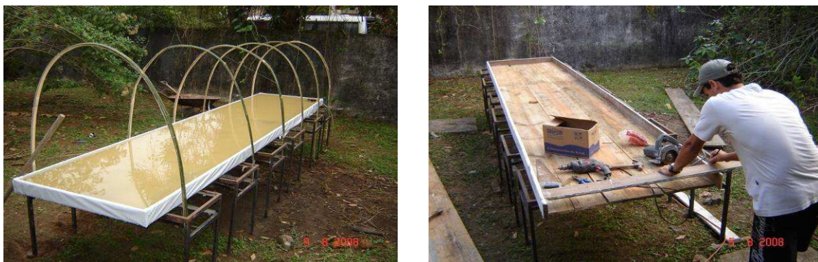
Figura 3.6 - Detalhes construtivos do estufim utilizado para germinação das sementes.
