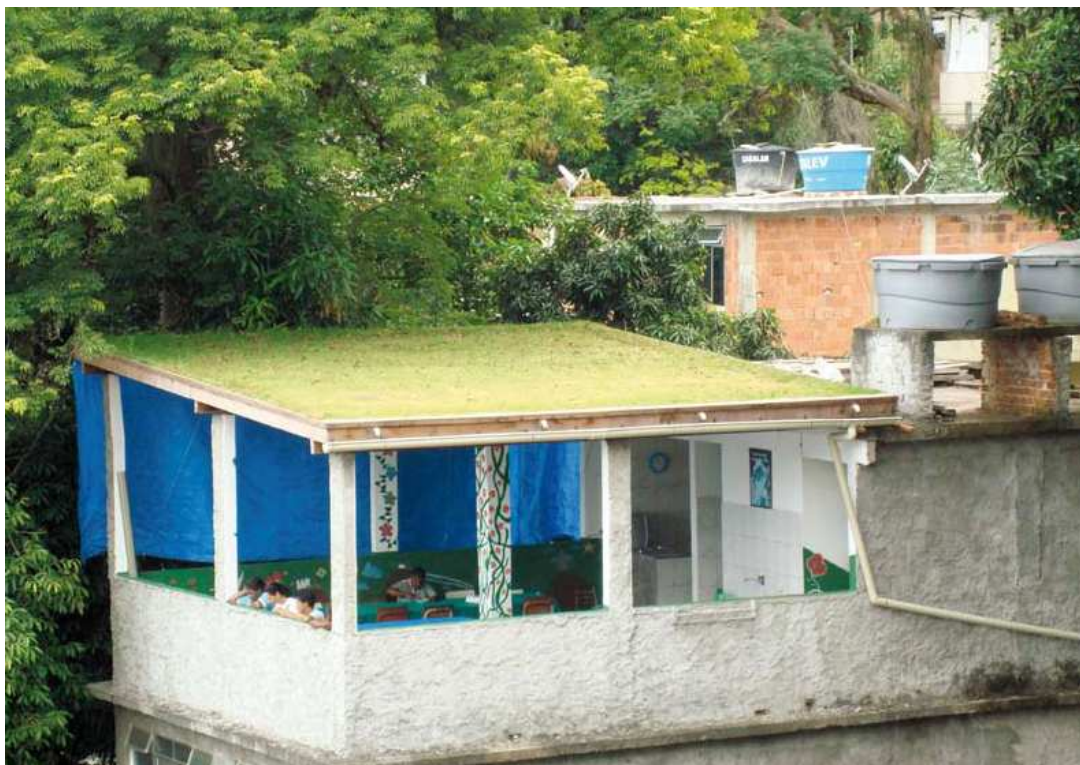
Figura 2.2 - Telhado Verde Extensivo – Morro da Babilônia – Leme (fonte : Revista CREA-RJ, dez 2008(pag.58) – Instituto Tibá).
