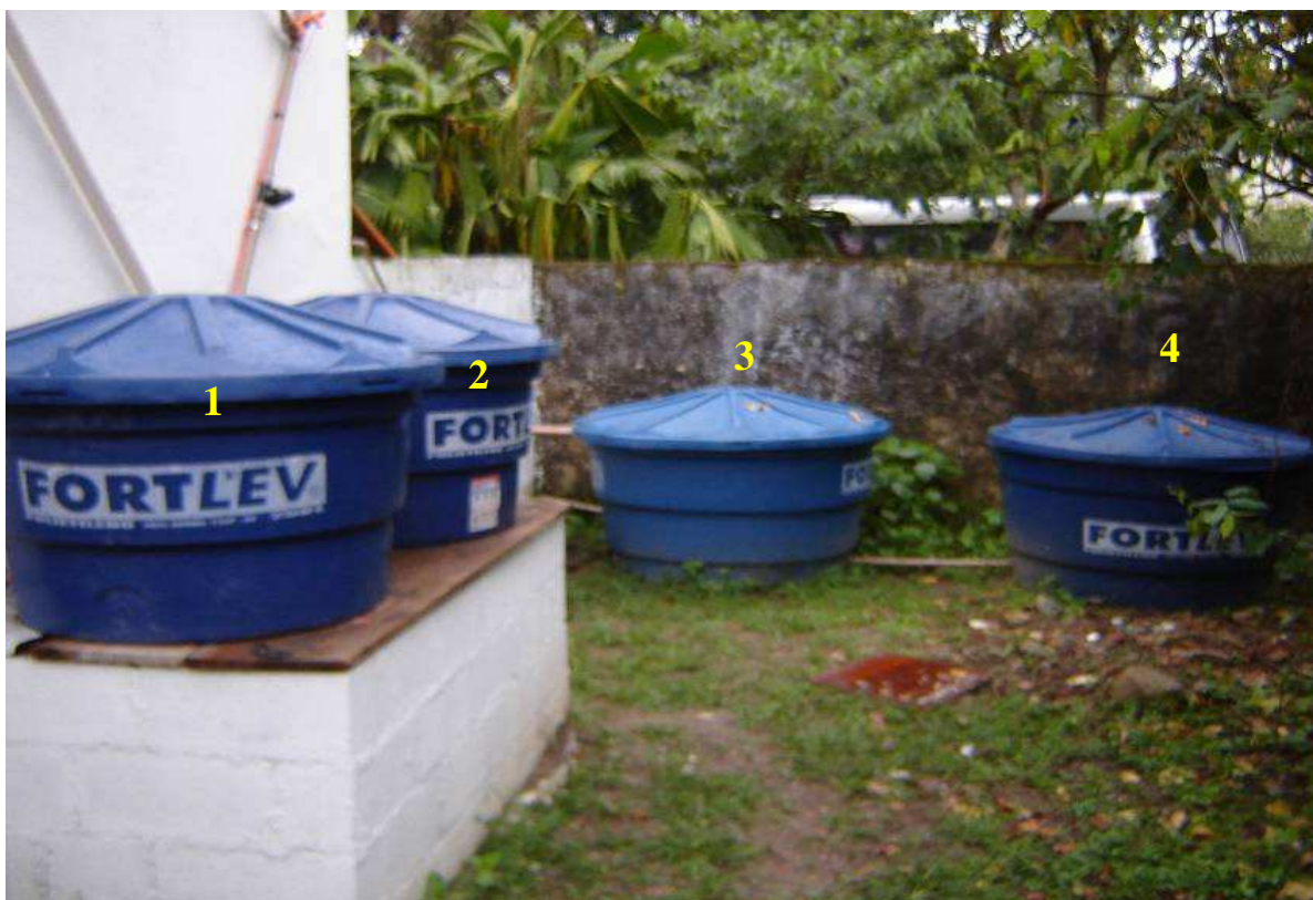
Figura 3.11 - Caixas de coleta da água proveniente do runoff nos dois telhados – sistemas independentes.
