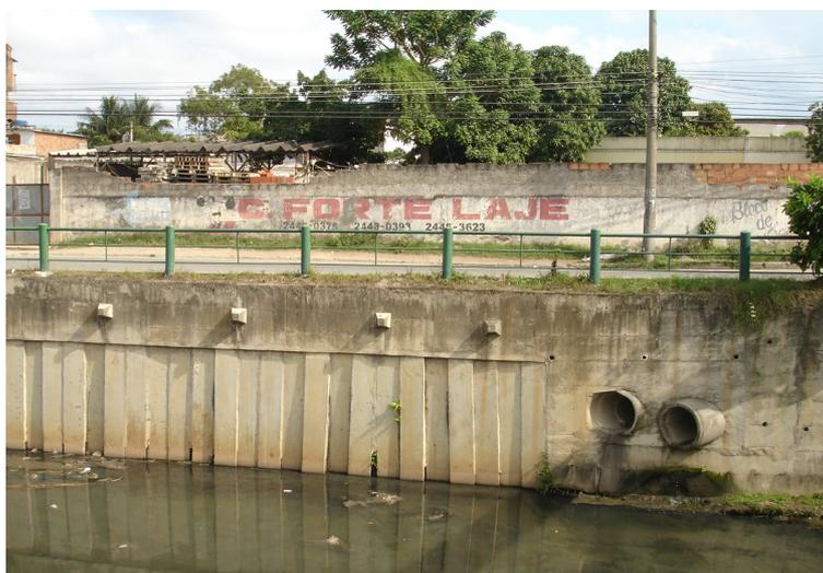
**Figura 5.12. Lançamento de esgoto diretamente no Rio Anil.**
