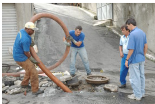
Figura 3. Desentupimento de galerias pluviais em Vitória-ES
