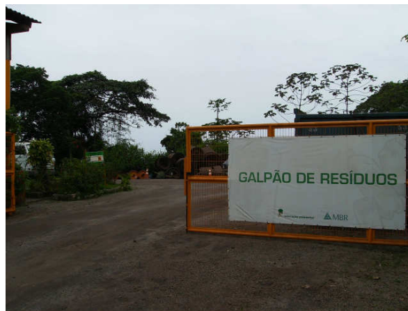
Galpão de armazenamento temporário.
