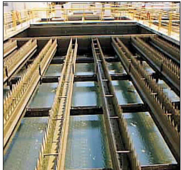
Figura 2.16 – Decantador sendo esvaziado para lavagem. Fonte: Reali (1999).
