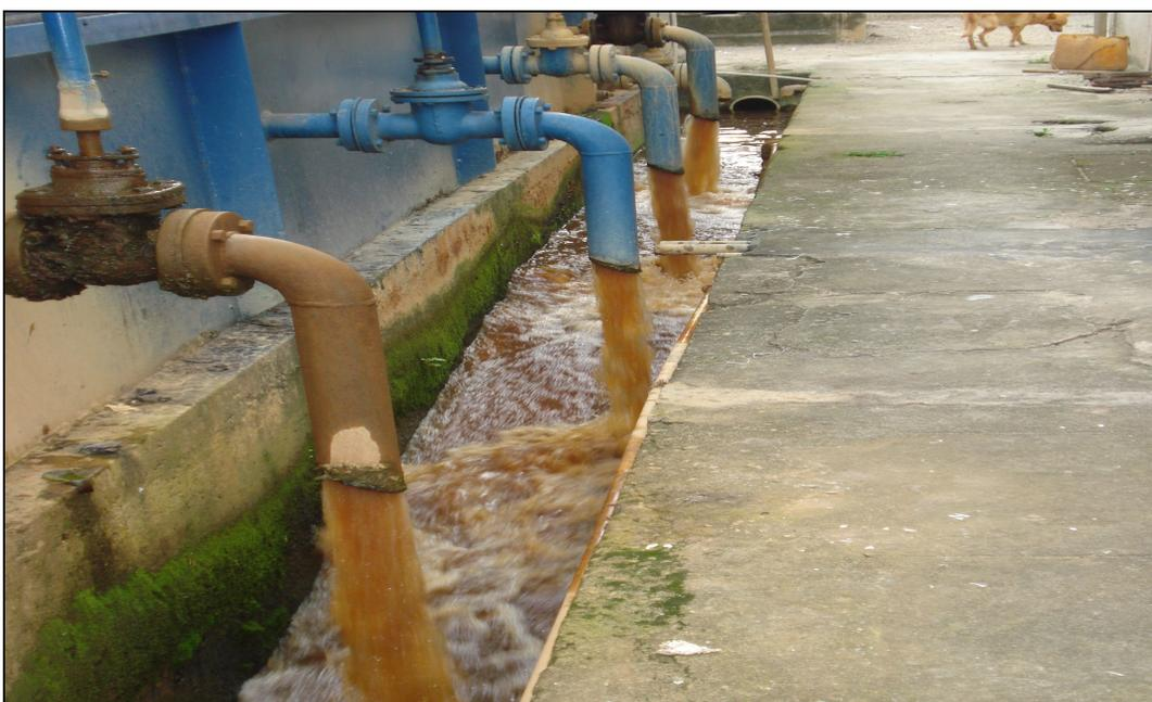
Figura 6.14 – Descargas de um decantador. Fonte: Arquivo do autor (2006).
