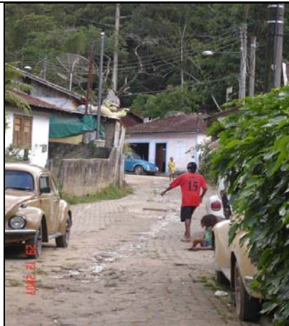
Foto 38: Calçamento irregular e vazamento de esgoto na Rua de Baixo
