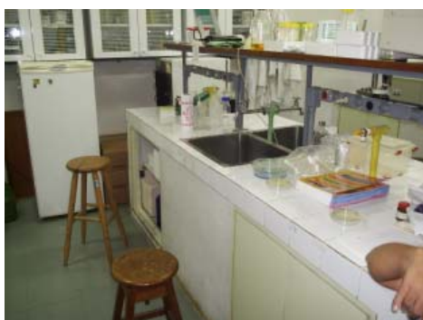
Foto 3- tomadas sem identificação de voltagem
