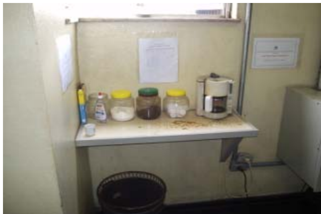
Foto 18- cafeteira no corredor de circulação, sem nenhuma higienização
